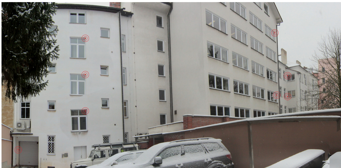
Obr. 2.2: Návrh rozvržení bodů prostorové sítě - pohled jihozápadní
