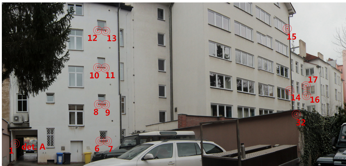
Obr. 3.2: Fotografie skutečného rozvržení bodů prostorové sítě - jihozápadní pohled
