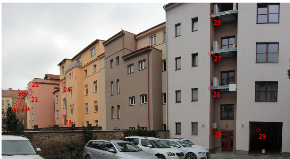
Obr. 3.4: Fotografie skutečného rozvržení bodů prostorové sítě - severozápadní pohled
