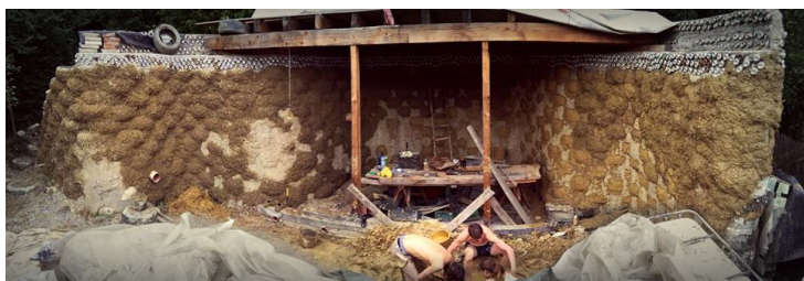
Zemělodka na Andělu, zadělávání pneumatik hliněnou směsí, foto by Hynek Opolecký
