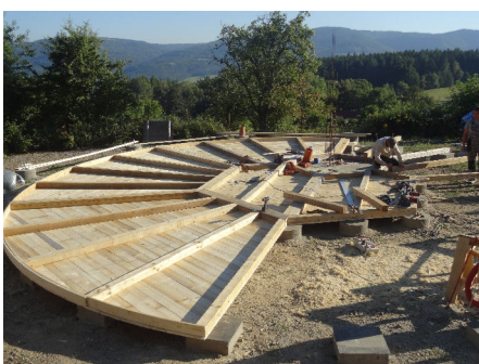
workshop Slamák v Krušných horách, Projekt Arc.Petra Hájka pro Maria Kubce, první část - stavba základové konstrukce
