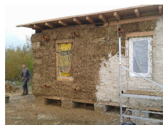
workshop Slamák v Uceebu, projekt pro několik diplomových prací, vyzkoušení si práce s hliněnými omítkami
