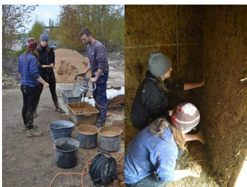
workshop Slamák v Uceebu, projekt pro několik diplomových prací, vyzkoušení si práce s hliněnými omítkami
