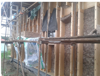
brigáda na dřevostavbě systpů z I profilů, SDK, minerální izolace foto vlastní
