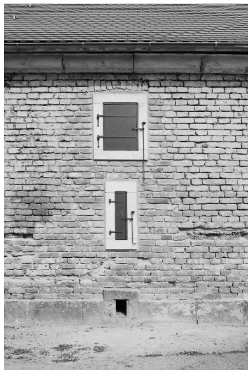
větrací otvory prachárny (bastion 3)
