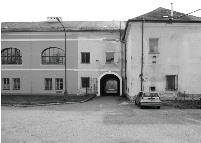
fasáda do dvora, vlevo sídlo NPÚ
