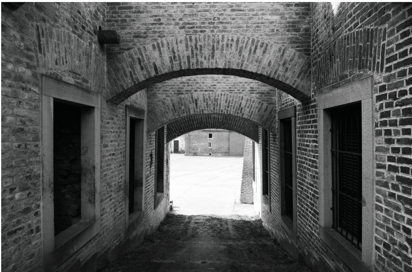
rampa z bastionu 1 na opevnění
