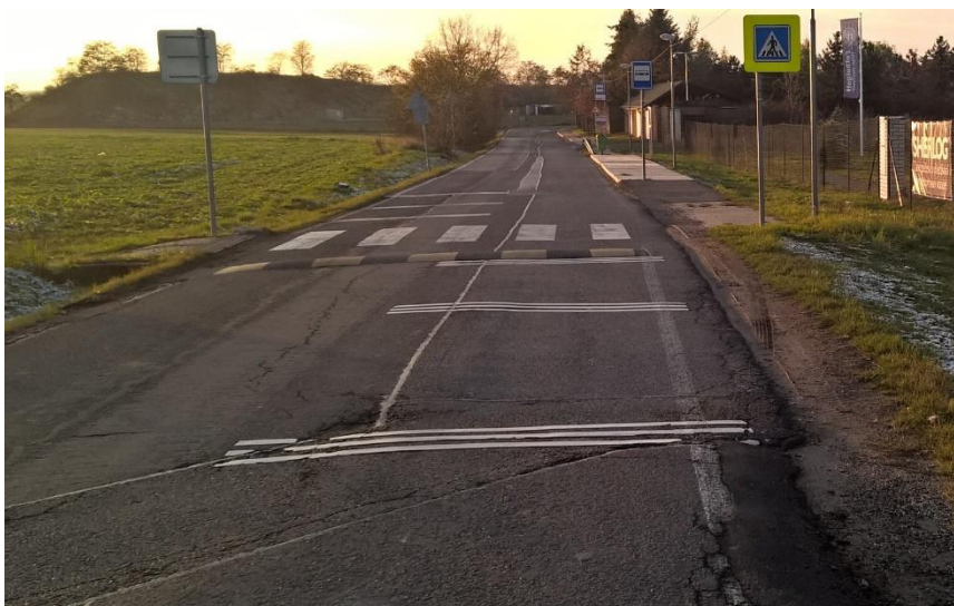
Obrázek 42 – Špatně provedená opticko-akustická brzda
