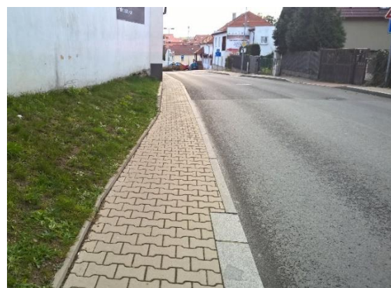
Obrázek 64 – Úzká chodníková plocha po pravé straně komunikace
