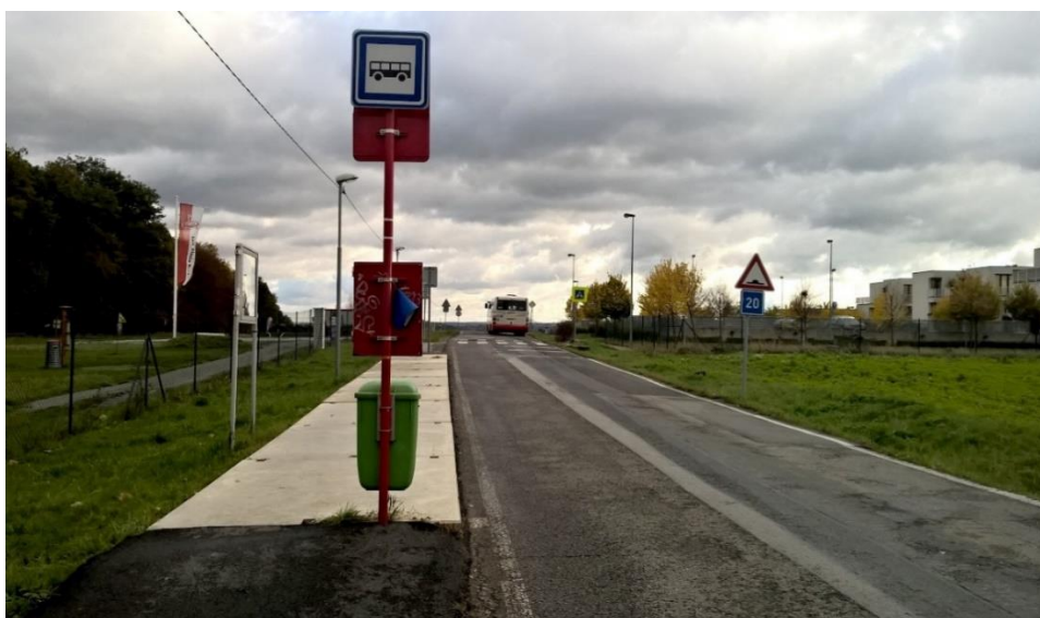
Obrázek 38 – Absence mobiliáře, špatně řešená zastávka MHD
