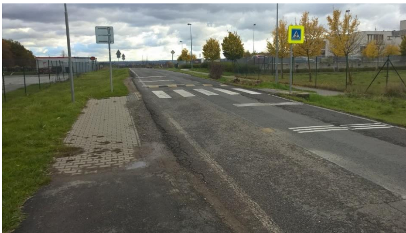
Obrázek 39 – Chodníková plocha pod úrovní vozovky
