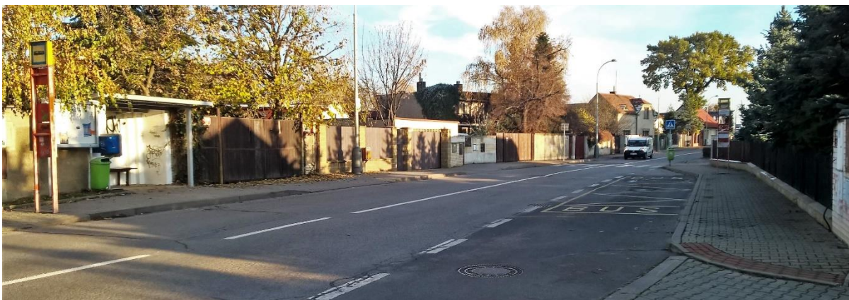
Obrázek 21 – Nevhodně provedené zastávky MHD
