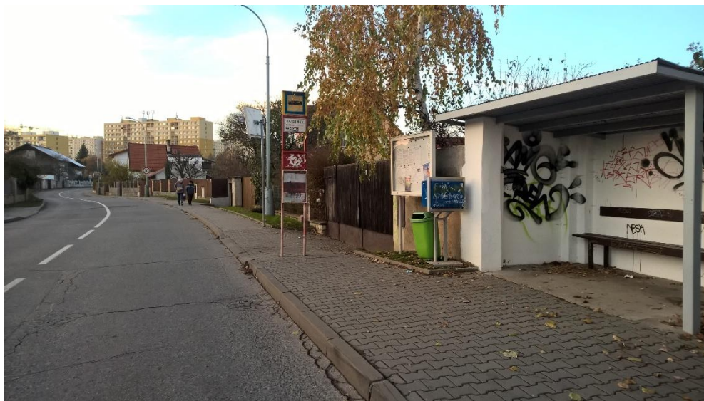
Obrázek 22 – Nevhodně provedená zastávka MHD - Kateřinky
