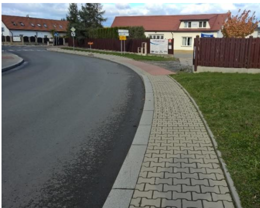
Obrázek 63 – Úzká chodníková plocha po levé straně komunikace
