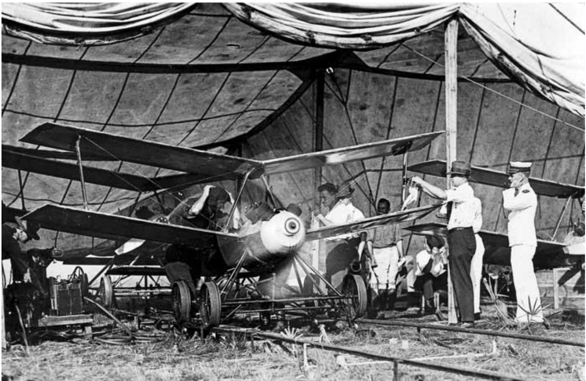
Obr. 1 Motorová zkouška prostředku Kettering Bug (vintagewings.ca [3])
