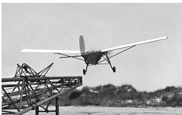
Obr. 12 Vzlet z katapultu, ukázka protiběžných vrtulí (NMAM [6])
