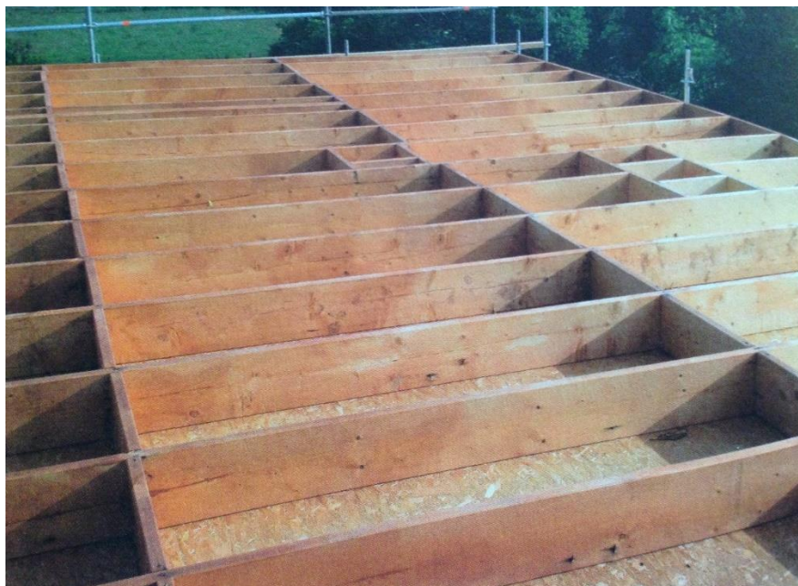
Obrázek 6 - Standartní stropní konstrukce TBF (1)
