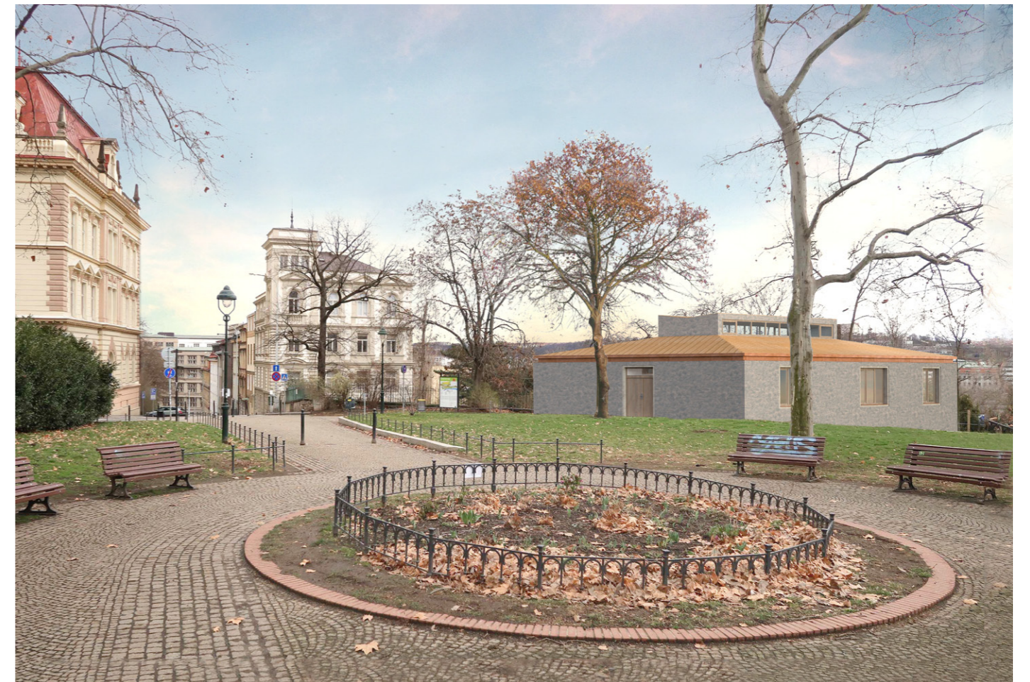
výška domu je zarovnaná s horizontem a umožňuje kolemjdoucím průhled světlíkem
