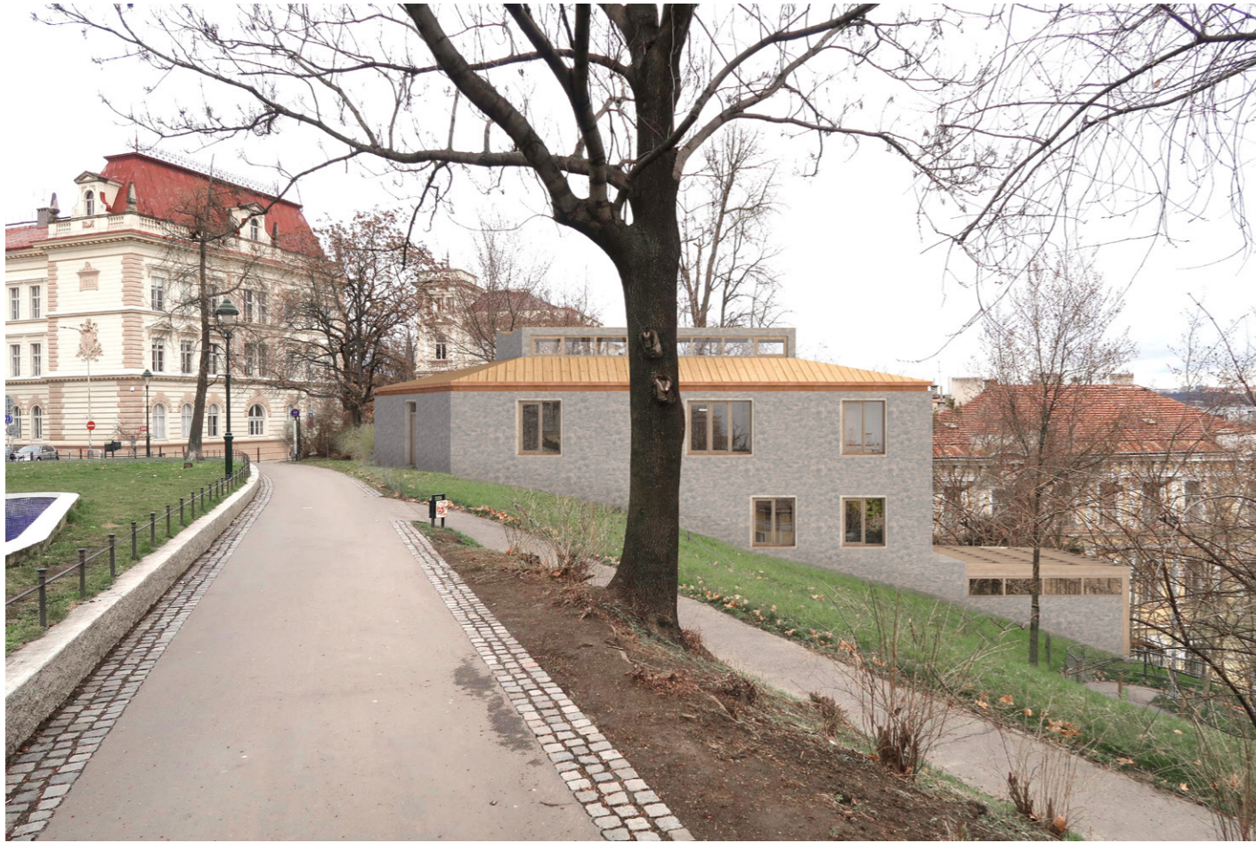
sestupování domu ze svahu, v pozadí dominantní škola a „zámeček“
