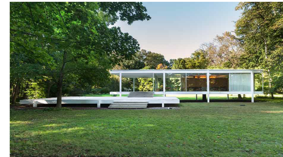
*Mies van der Rohe, Farnsworth House
