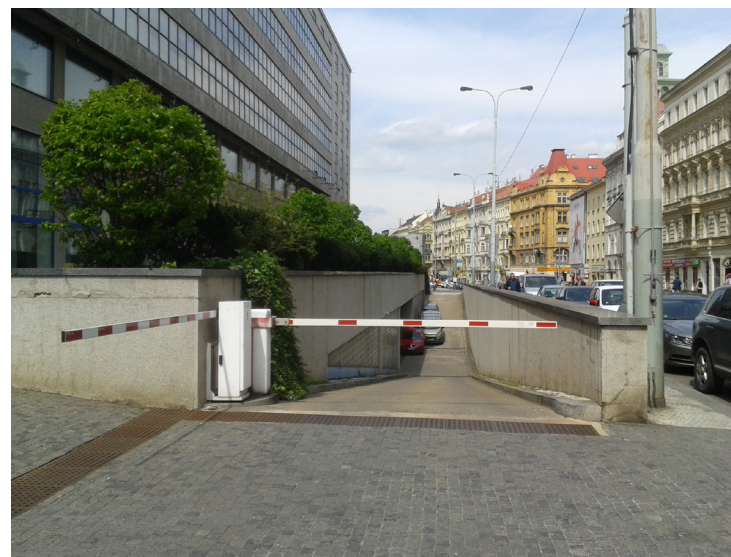
Rampa, na které parkují vozidla, zdegradované materiály, závory tvořící bariéry.
