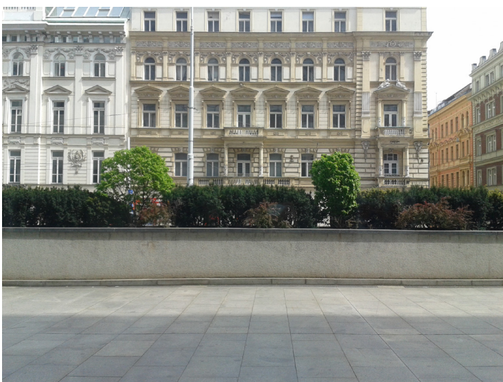
Výhled do zdi z kavárny v přízemí.
