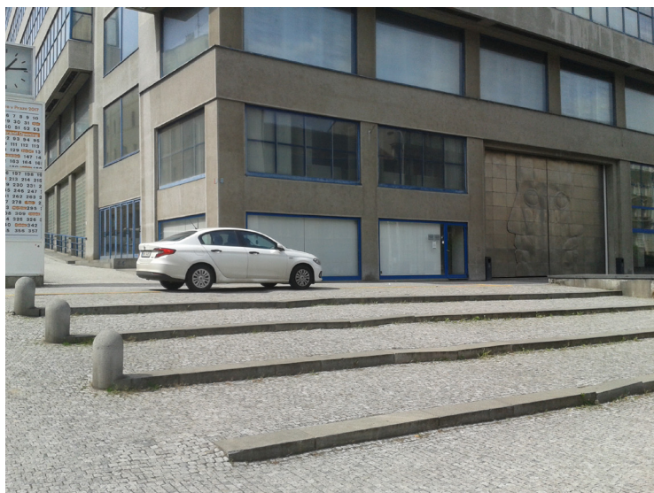
Parkující vozidla na ploše, zbytečné schůdky bránící pohybu handicapovaných osob.
