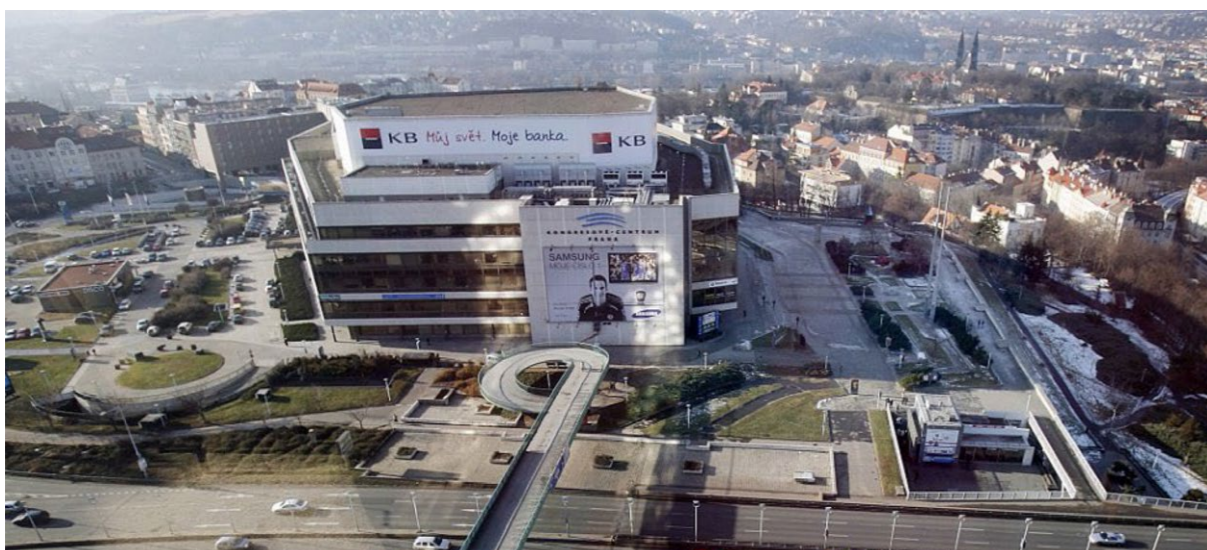
Pohled na KCP a jeho okolí ze střechy hotelu Corinthia
