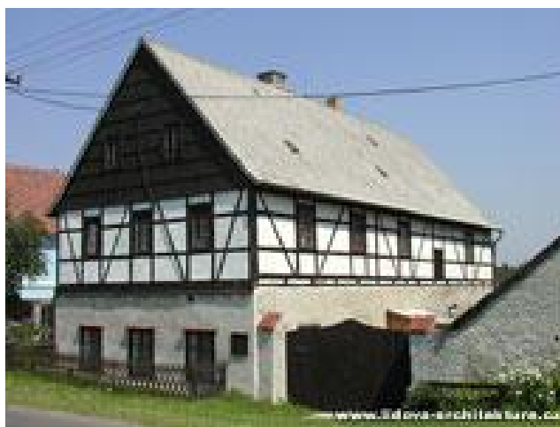
Obr. 3: Hrázděná konstrukce patra domu [4]
