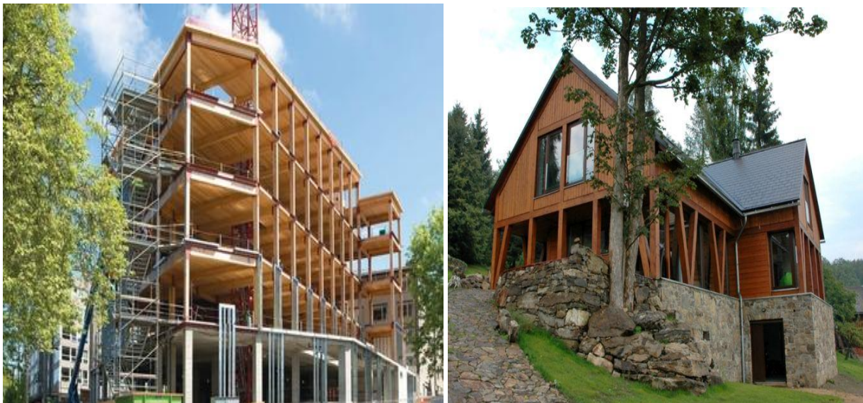
Obr. 10: Nosný skelet z lepeného lamelového dřeva budovy Bullitt Centre ve Washingtonu [10]
