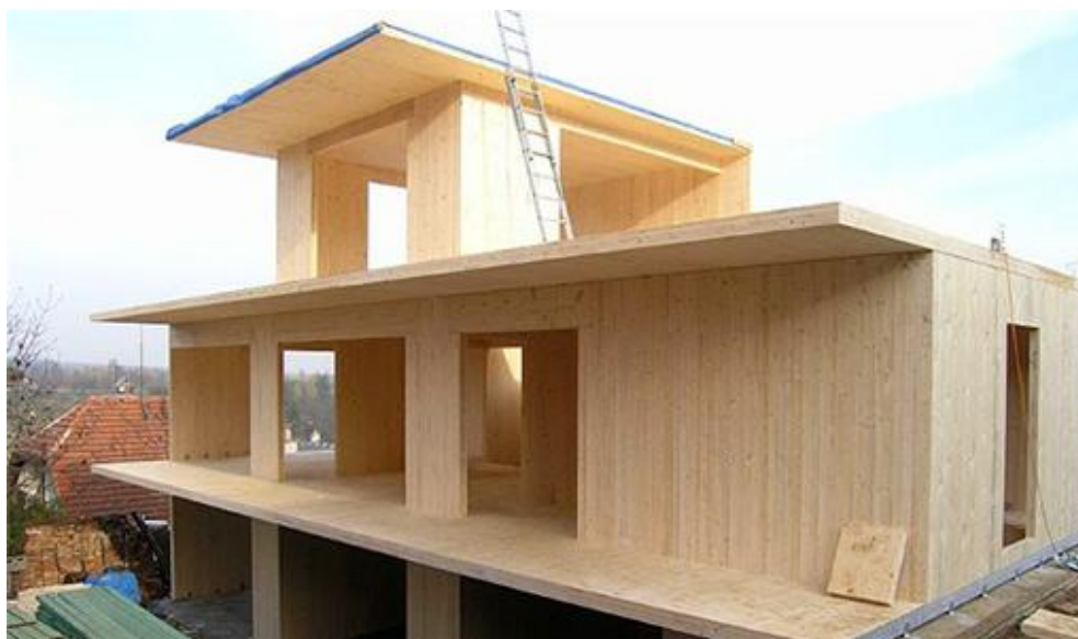
Obr. 6: Stavba z masivních dřevěných panelů [8]
