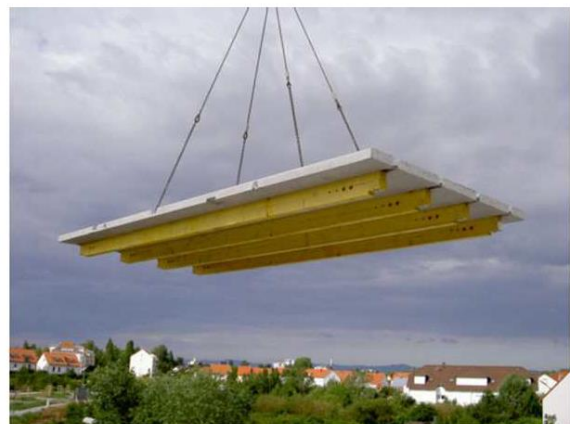
Obr. 9: Výroba a montáž prefabrikovaného dřevobetonového stropu [4]
