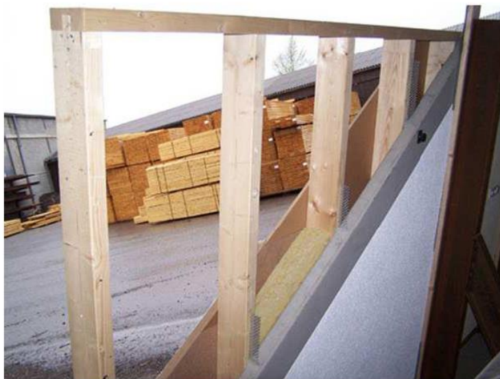
Obr. 12: Dřevobetonová stěna [4]
