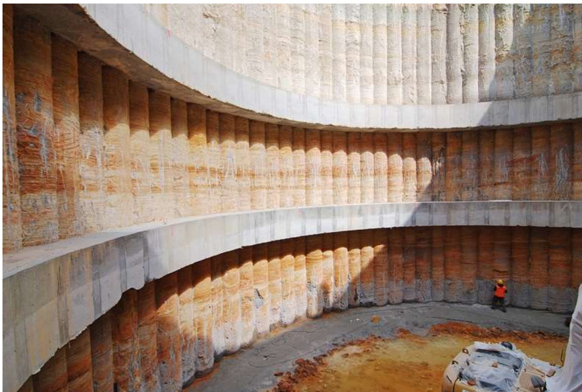
Obr. 015: Pilotová stěna s předsazenou převázkou [25]
