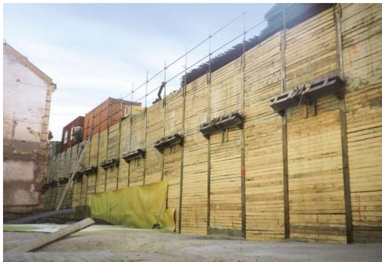
Obr. 011: Stěna záporového pažení [22]
