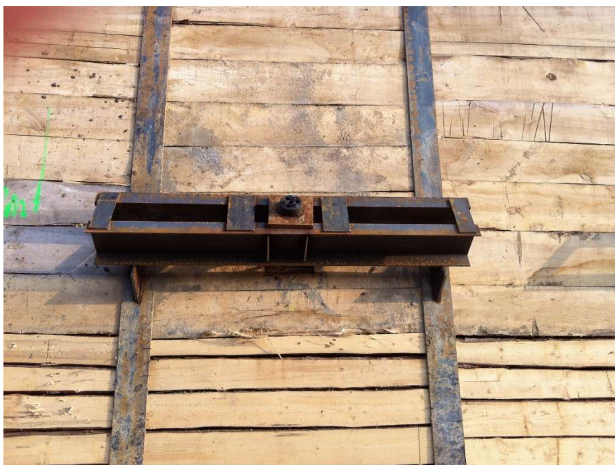
Obr. 020: Ocelová převázka u záporového pažení [29]
