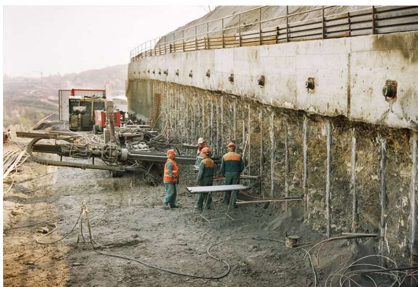
Obr. 012: Mikrozáporové pažení [23]
