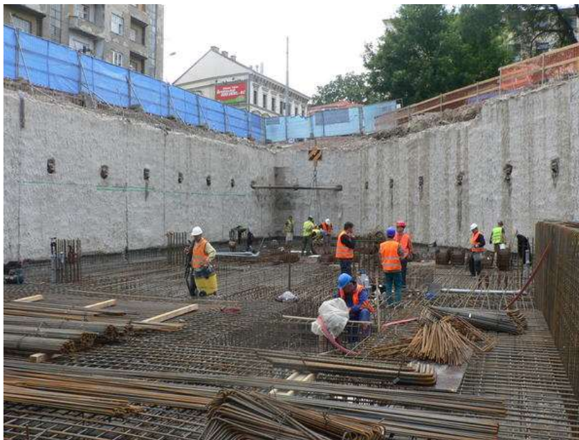
Obr. 016: Podzemní stěna [26]
