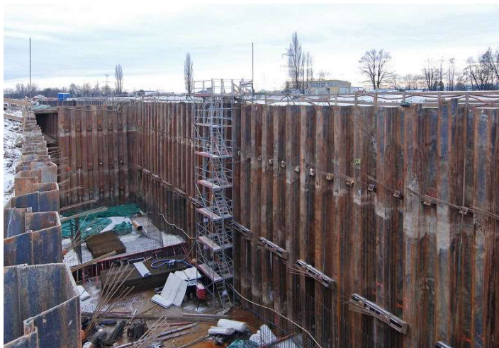
Obr. 013: Štětová stěna z ocelových profilů [24]
