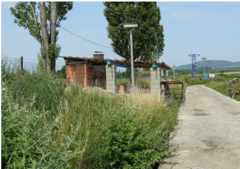
Obr. 10: Fotografie stavebního objektu SO 09
