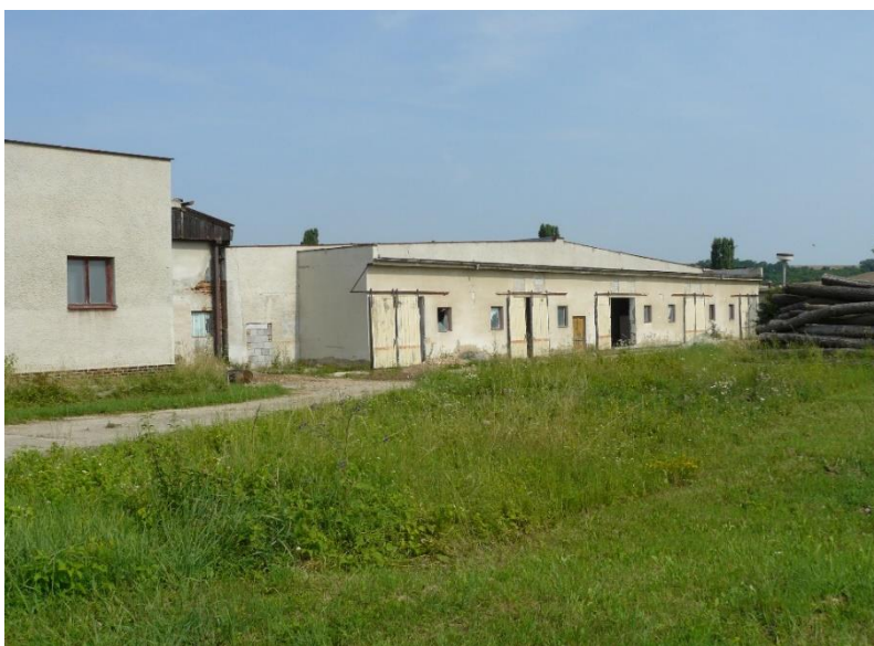
Obr. 6: Fotografie stavebního objektu SO 02
