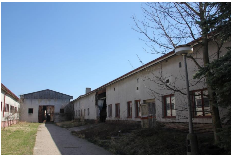
Obr. 3: Fotografie stavebního objektu S0 O1 – stávající stav
