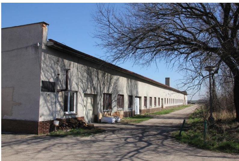
Obr. 4: Fotografie stavebního objektu S0 O1 – stávající stav
