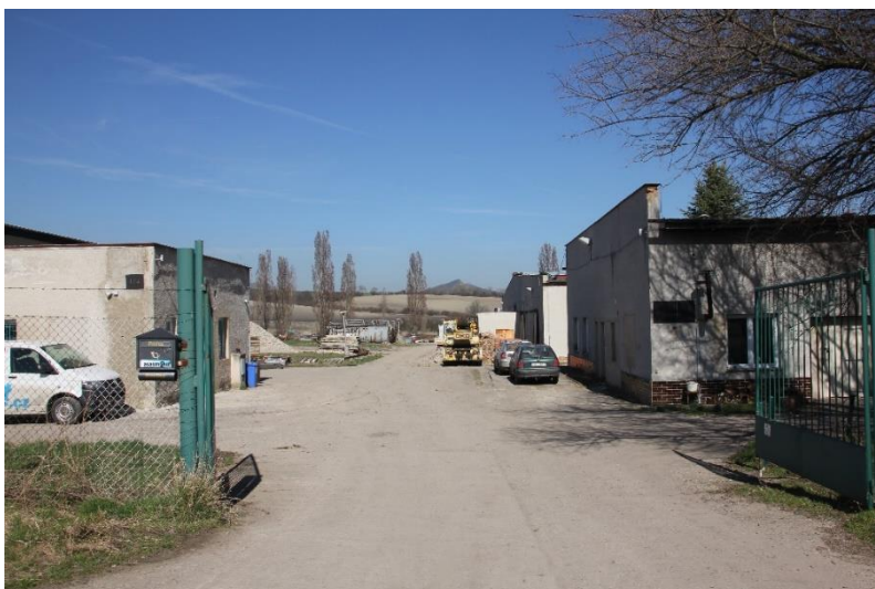
Obr. 13: Fotografie stavebního objektu SO 08, SO 09
