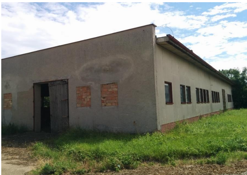
Obr. 7: Fotografie stavebního objektu SO 03
