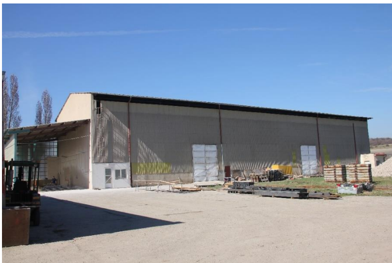
Obr. 8: Fotografie stavebního objektu SO 04
