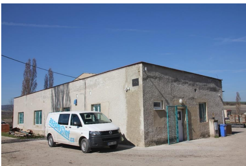
Obr. 9: Fotografie stavebního objektu SO 05
