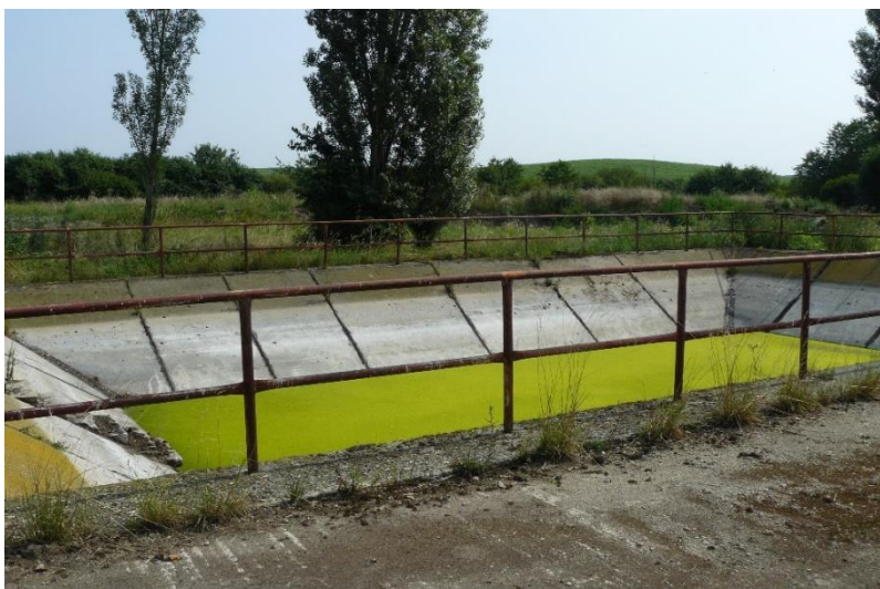
Obr. 11: Fotografie stavebního objektu SO 06
