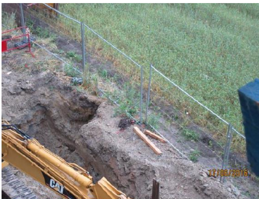
Foto 4: Porušení souvislosti oplocení
