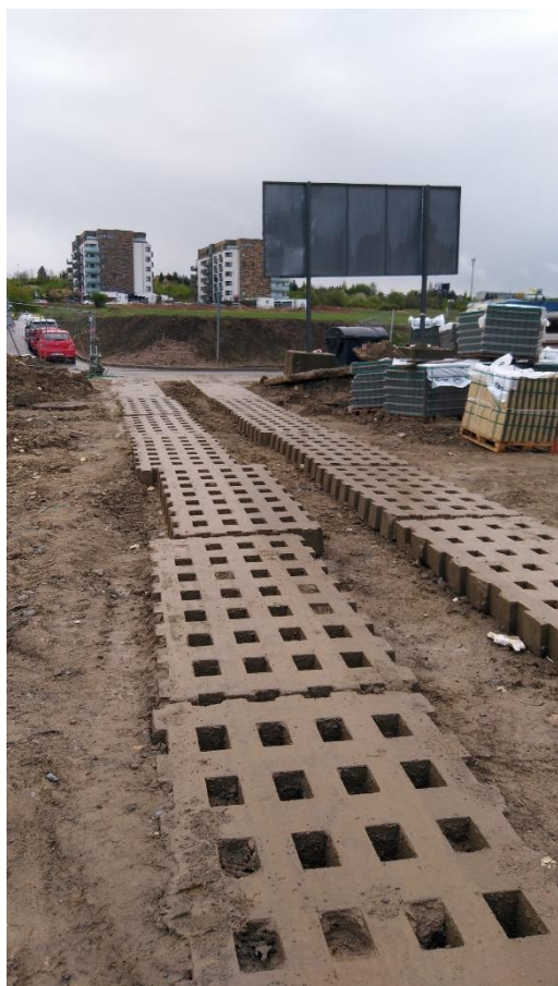
Foto 6: Hlavní vstup a vjezd na stavenišť. Chyby vstupní a vjezdová brána. Chybí oddělení pěší zóny od dopravní cesty.
