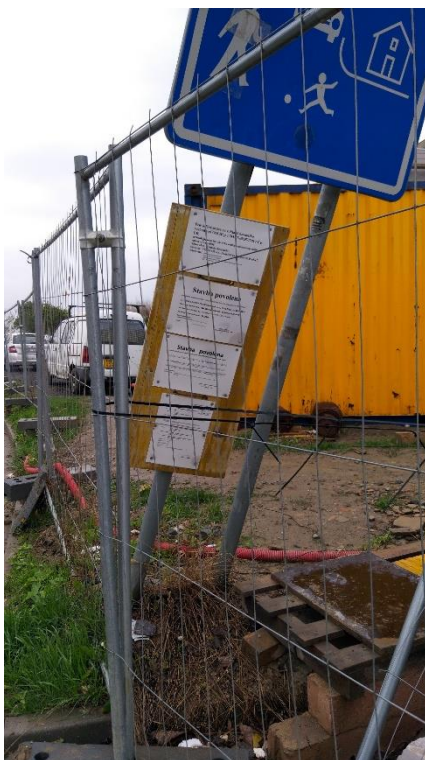
Foto 5: Informační tabule se stavebním povolením a základní informace o stavebníkovi a objektu. Správně by měla být umístěna vedle hlavního vstupu/vjezdu do objektu. Skutečně je někde cca 20 m a není je vidět.
