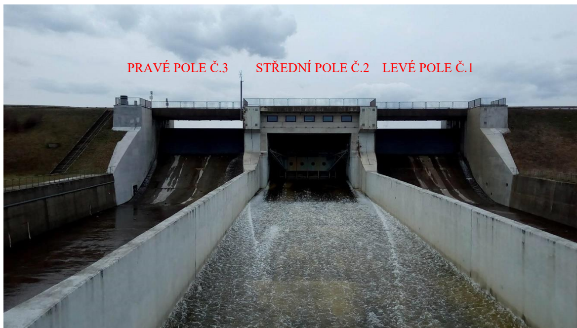
Obr. 2.3 - Pole bezpečnostního přelivu
