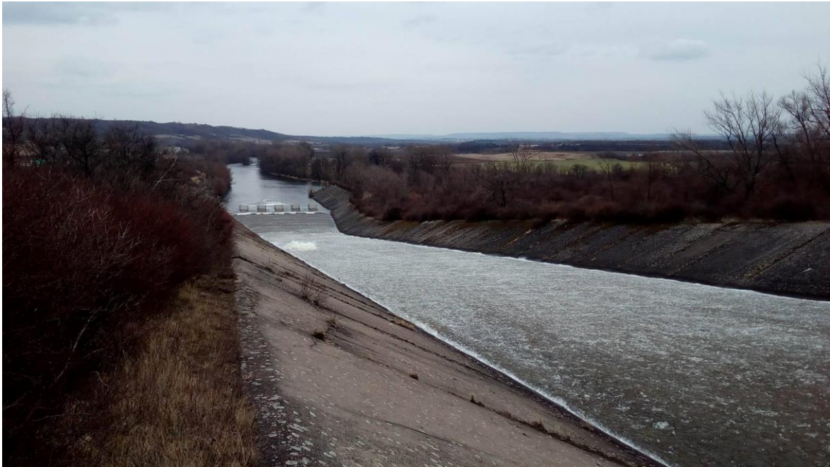
Obr. 11.2 - Fotografie střední a dolní části skluzu bezpečnostního přelivu VD Nechanice
