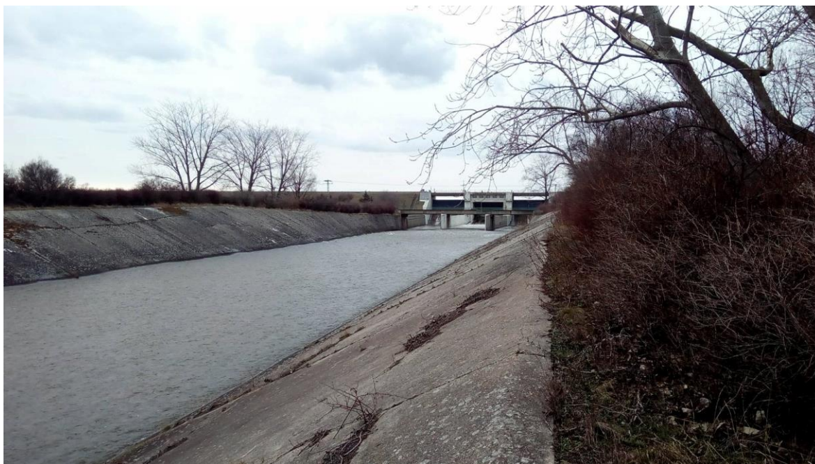
Obr. 11.1 - Fotografie horní části skluzu bezpečnostního přelivu VD Nechanice
