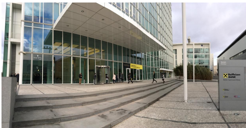
Obr. 7 - Hlavní vstup do objektu [Archiv studentky]
