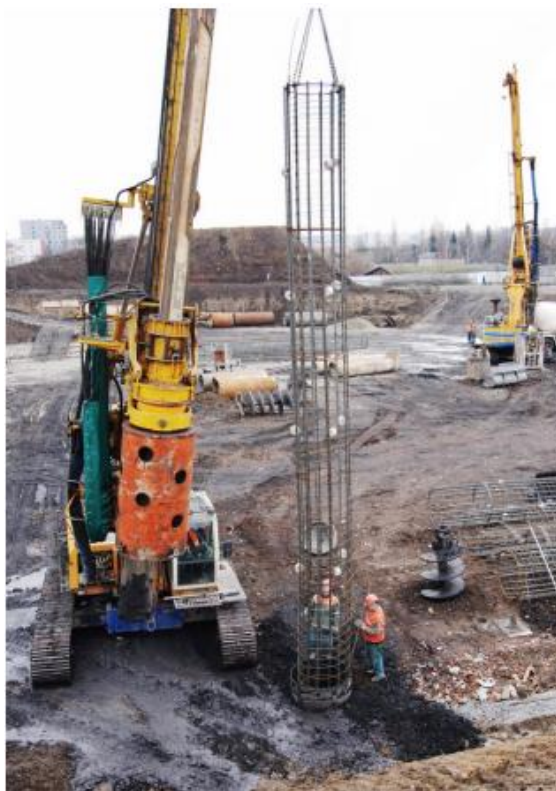
Obr. 15 - Vkládání armokoše do zapaženého vrtu [24]
