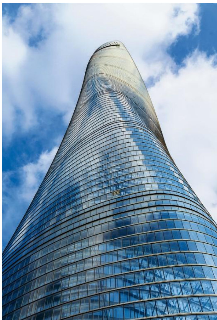
Obr. 43 - Dokončená Šanghajská věž [9]
