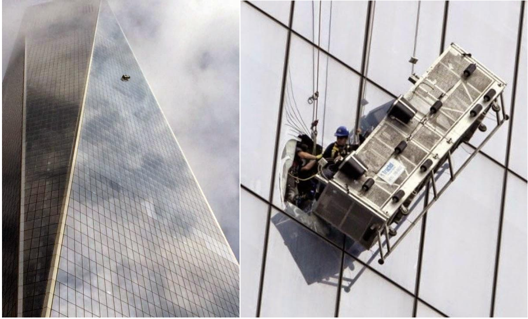
Obr. 34 - Nehoda při čištění fasády [32]
