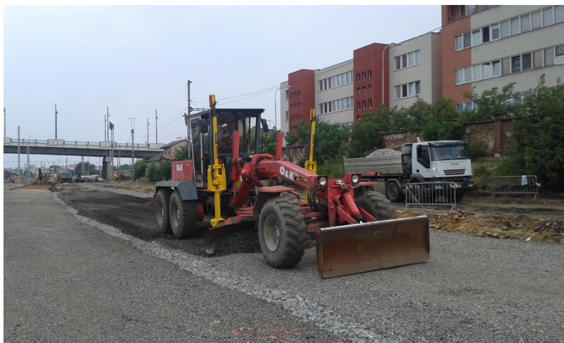
Obr. 4.4 - Grejdr s nivelačním systémem navádění
