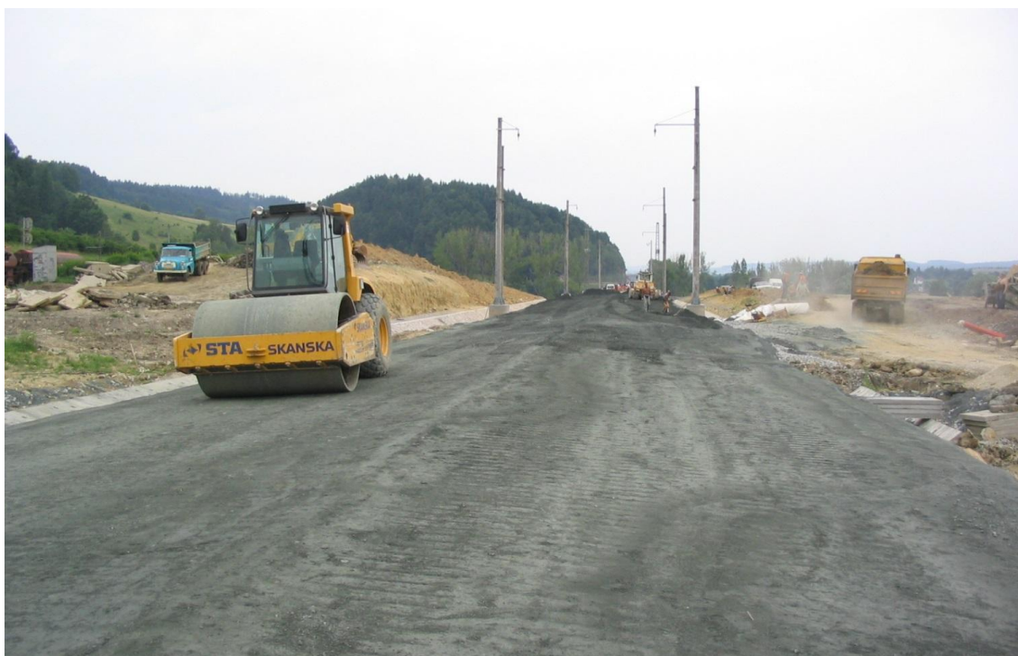
Obr. 4.1 - Hutnění vibrační válcem [14]
