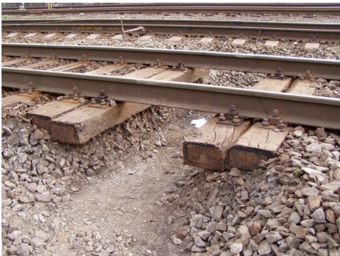
Obr. 5.2 - Rýha pro umístění těžícího řetězu [22]
