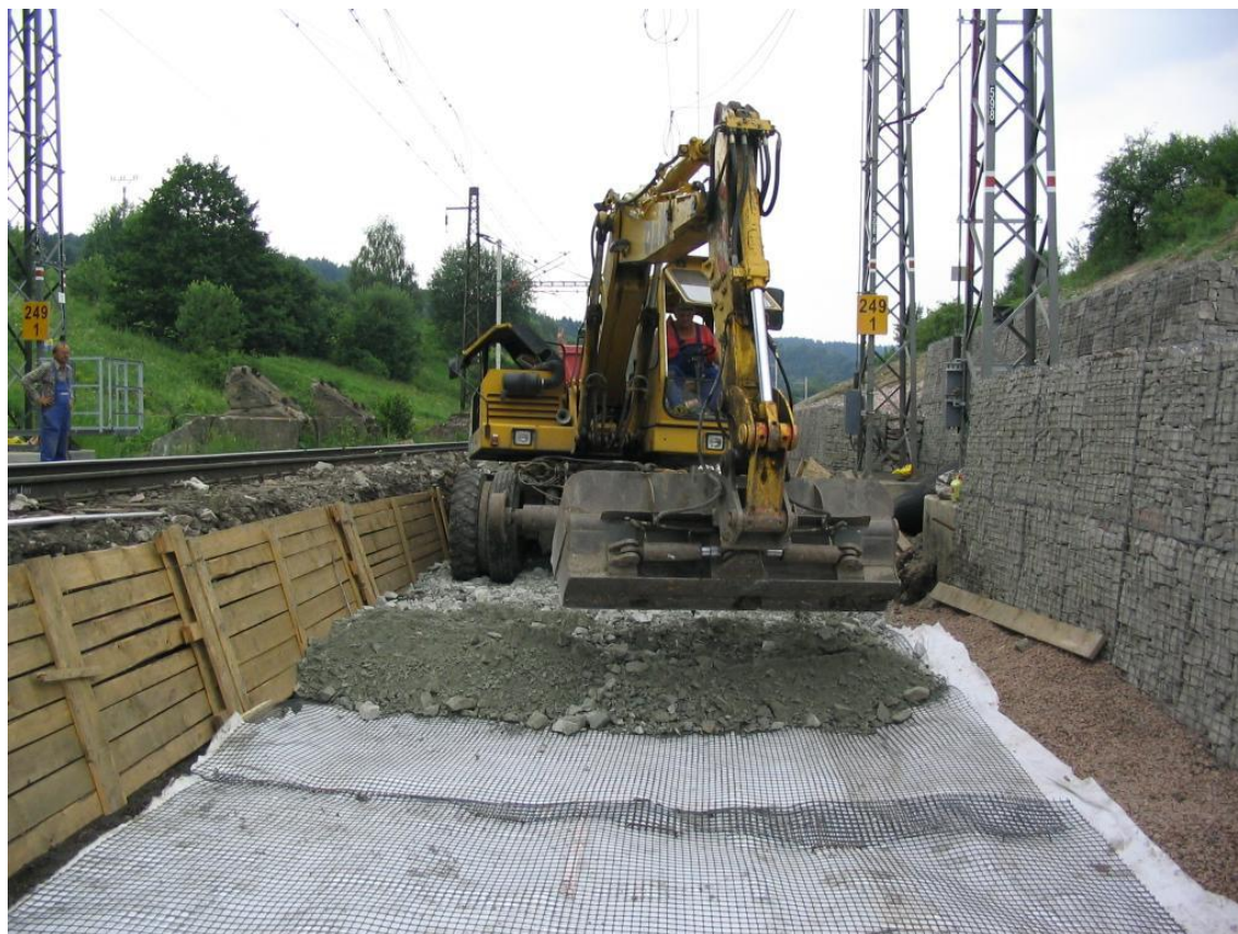
Obr. 4.3 - Instalace konstrukční vrstvy na uložená geosyntetika [14]
