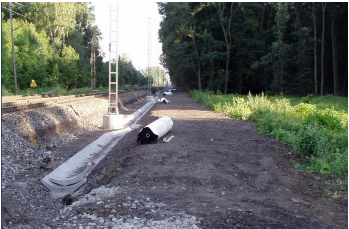
Obr. 5.1 - Příprava geosyntetik a jejich rozmístění podél tratě [22]
