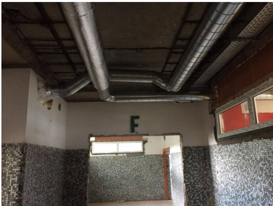
Obr. 18: Oprava špatného napojení [Vytvořeno autorem]
