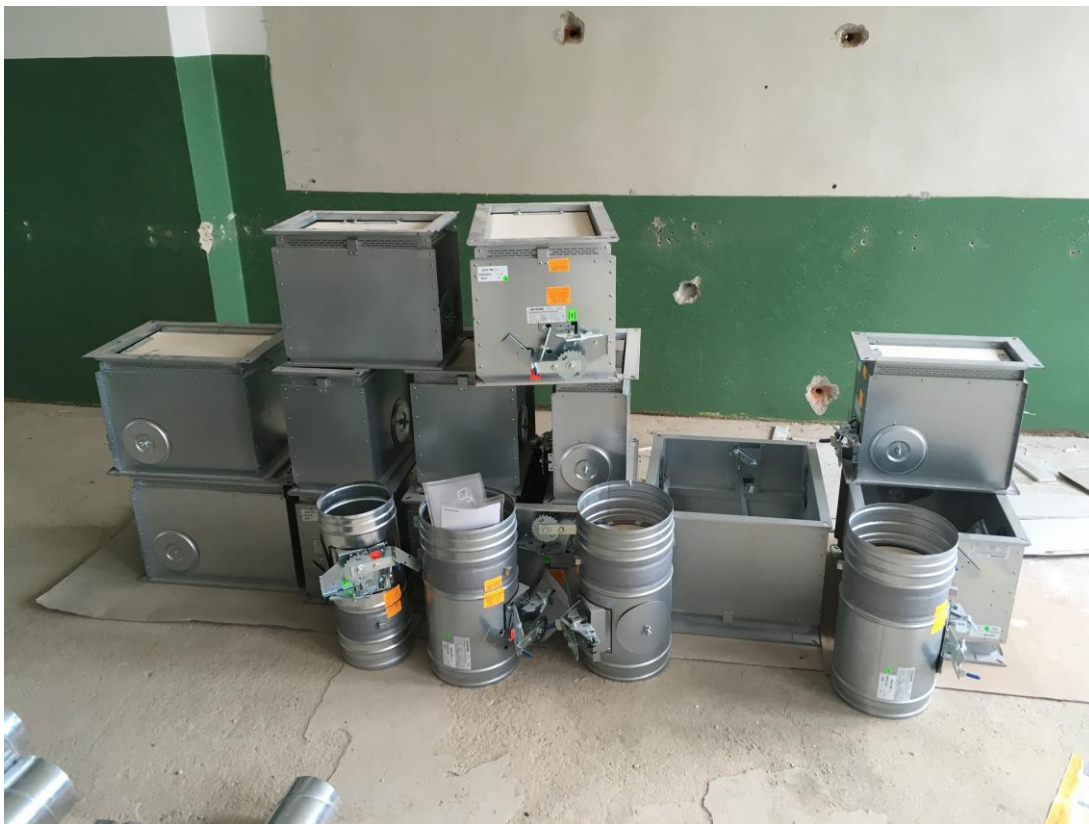
Obr. 14: Požární klapky [Vytvořeno autorem]
