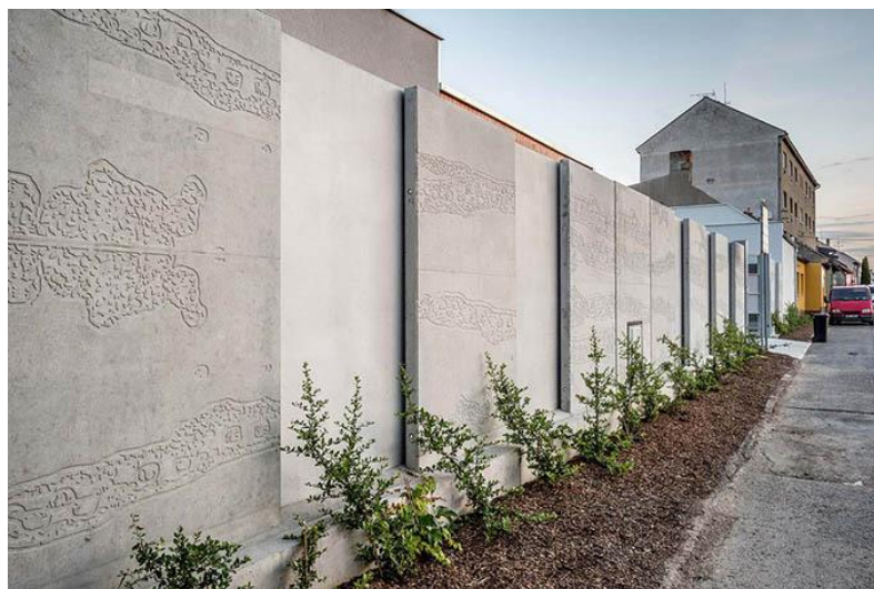
Obr. 18: Příklad použití zdí s výtvarně řešeným reliéfem [17]
