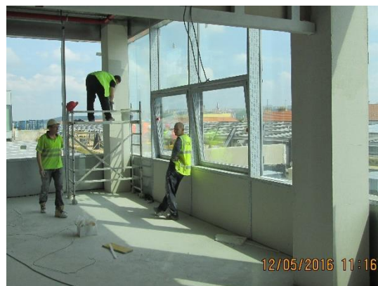
Obrázek 99 – budova B – špatná konstrukce lešení – nízké zábradlí a okopová lišta, pracovník na lešení nepoužívá OOPP (archiv autora)
