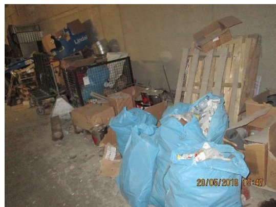
Obrázek 127 – budova B – nepořádek na stavbě, špatné skladování materiálu (Archiv autora)
