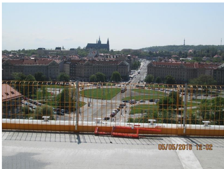
Obrázek 196 – budova A – dobře zabezpečená hrana proti pádu (archiv autora)
