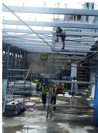
Obrázek 170 – budova B – špatná konstrukce lešení – nízké zábradlí, chybí středový prvek a okopová lišta (archiv autora)
