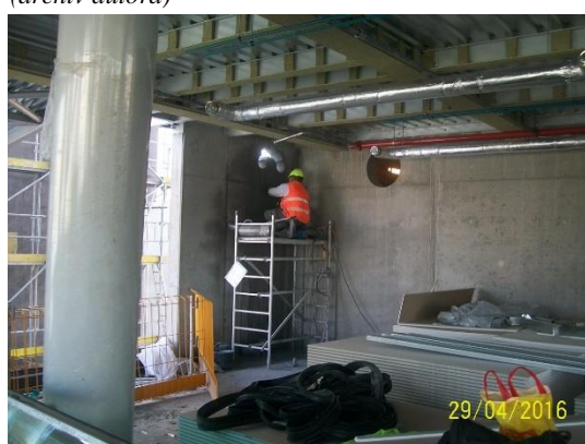
Obrázek 61 – budova A – špatná konstr. lešení – nízké zábradlí, chybí střed. prvek a okopová lišta (archiv autora)
