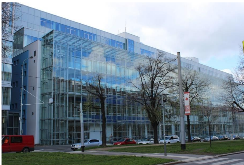
Obrázek 5- budova B - pohled z ulice Jugoslávských partyzánů [zdroj: 6]
