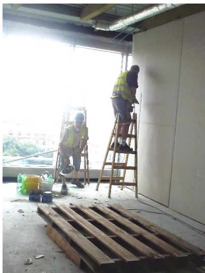
Obrázek 171 – budova A – špatné užívání dvojitého žebříku, pracovník nepoužívá OOPP - pracovní helma (archiv autora)
