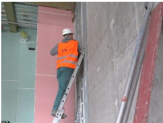
Obrázek 42 – budova A – špatné užívání žebříku – provádění těžkých prací na žebříku, nestabilní konstrukce žebříku, pracovník nepoužívá OOPP – ochranu očí apod. (archiv autora)
