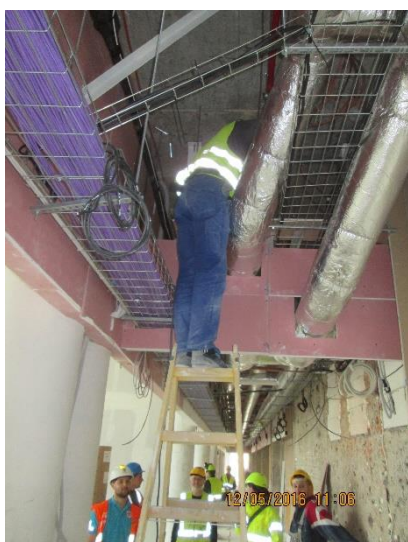
Obrázek 106 – budova B – špatné užívání dvojitého žebříku (archiv autora)
