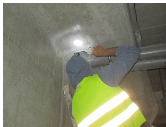
Obrázek 135 – budova A – špatné užívání žebříku, pracovník nepoužívá OOPP – pracovní helmu (archiv autora)
