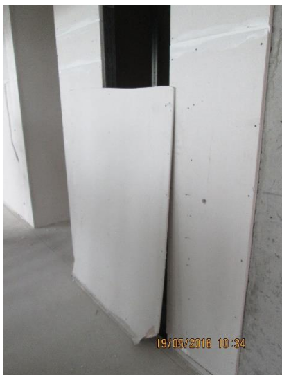
Obrázek 136 – budova B – špatné zvolené zajištění proti pádu – nedostatečně únosný, u přibití vyčnívají hřebíky (archiv autora)
