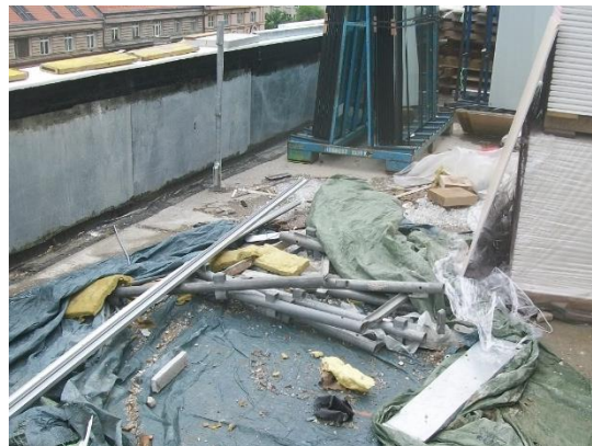
Obrázek 82 – budova B – nezabezpeč. lehký materiál proti odlétnutí, nepořádek na stavbě, špatné skladování materiálu (Archiv autora)
