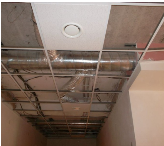
OBRÁZEK 24 Zdravotnické centrum Kalná nad Hronom, připojení talířových ventilů umístěných v podhledu pomocí flexi potrubí ke kruhovému potrubí, www.najklima.cz
