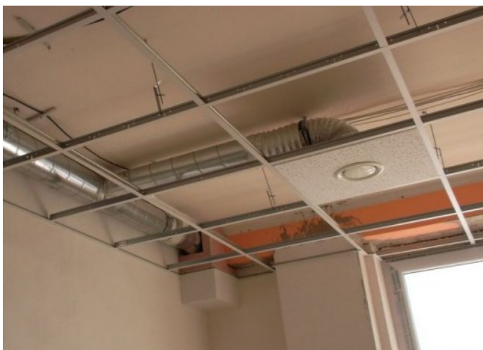
OBRÁZEK 24 Zdravotnické centrum Kalná nad Hronom, připojení talířových ventilů umístěných v podhledu pomocí flexi potrubí ke kruhovému potrubí, www.najklima.cz
