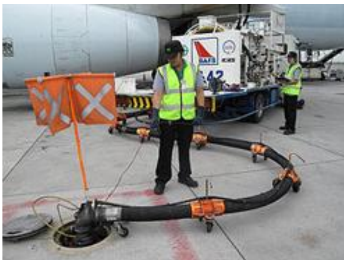
Obrázek 19 – Označení otevřené jímky hydrantového rozvodného systému zdroj: http://www.tarco.co.th [71]
