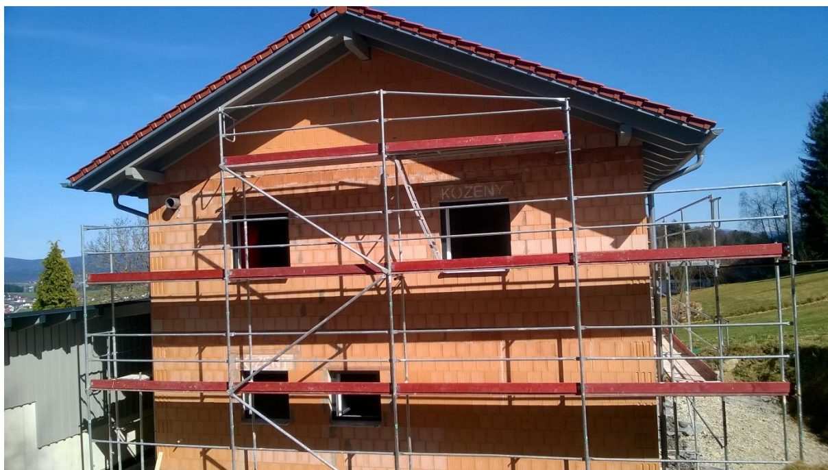
Obr. 35: Stěna F – Sestavy lešení byly posunuty o 0,5 m doprava z důvodu kolize se střechou přístřešku vlevo. Kvůli tomu nebylo možné na jednom místě umístit sloupek zábradlí v nejvyšším patře. Namísto něj byla použita kotva a závlačná spojka.
