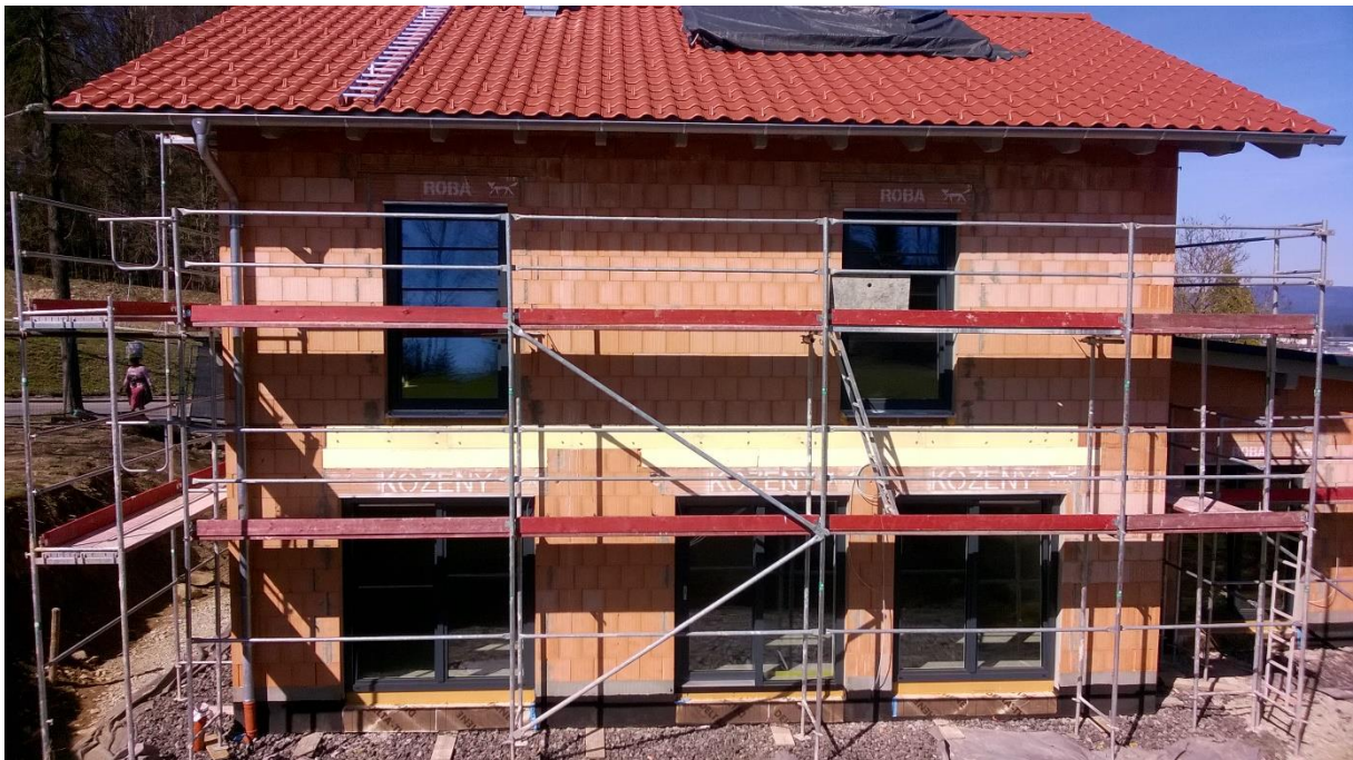
Obr. 30: Stěna A – Montáž byla provedena podle plánu.
