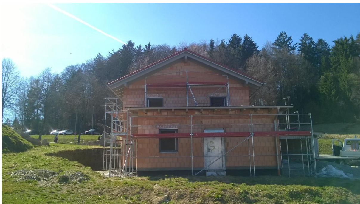
Obr. 32: Stěna D: Montáž byla provedena podle plánu
