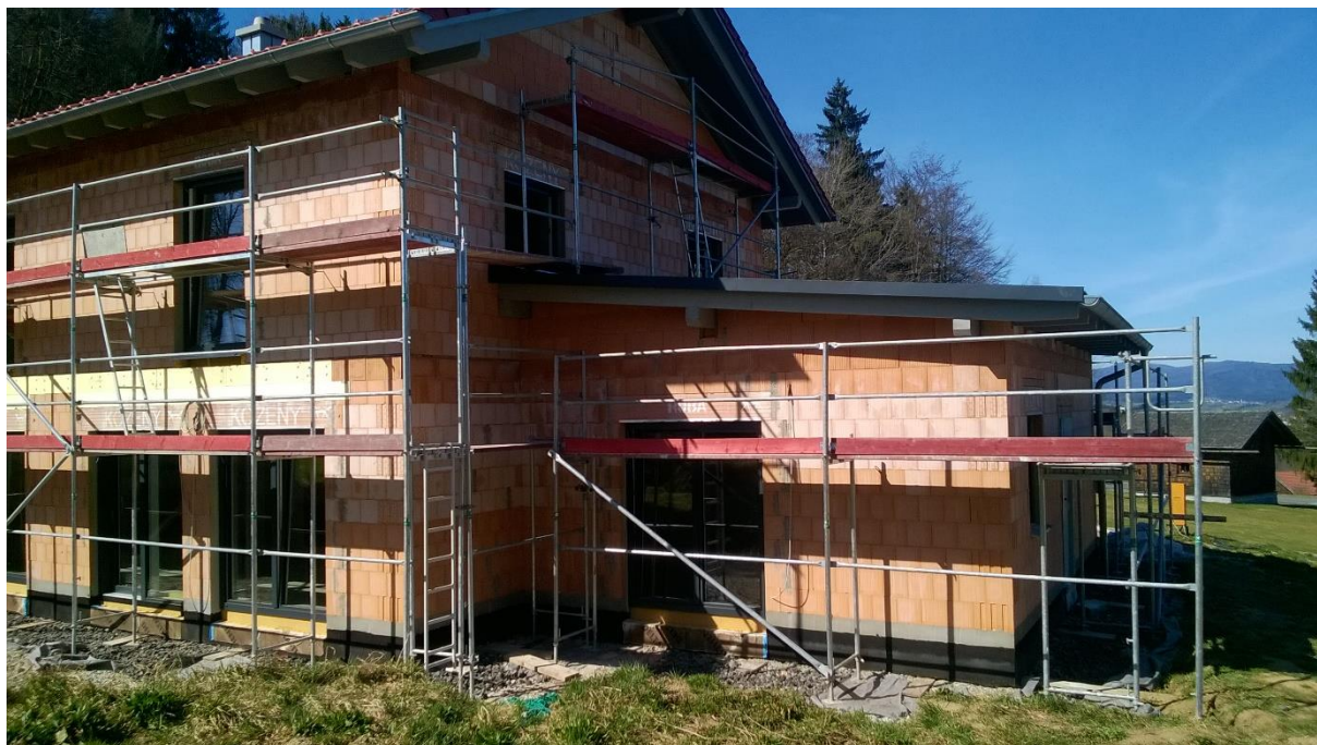
Obr. 31: Stěna B – Během montáže bylo 2. patro namísto 2 m podlahy opatřeno 3 m podlahou s přesahem na plochu střechu přístěnku.
