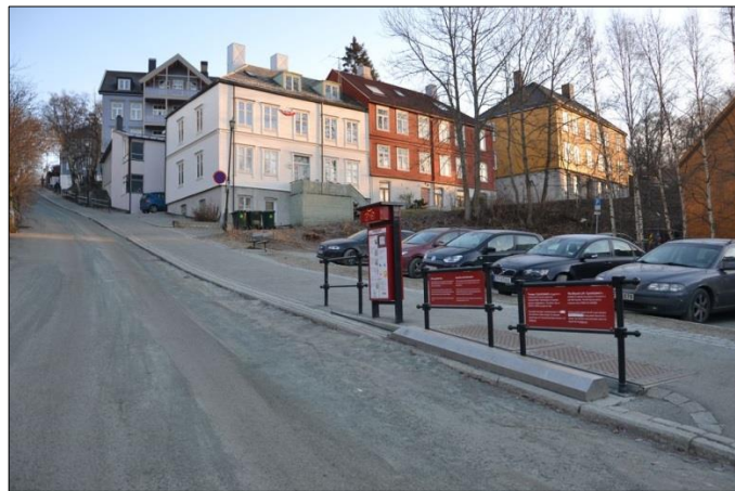
Obrázek 3-3 Pohled na výtah zespod [6]
