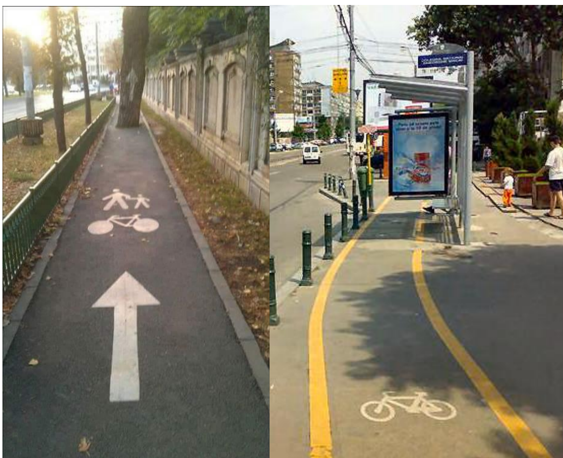
Obrázek 2-6 Nevhodné vedení cyklostezky [26]
