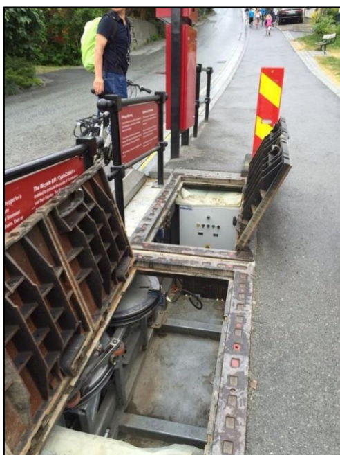
Obrázek 5-1 Strojovna výtahu [36]
