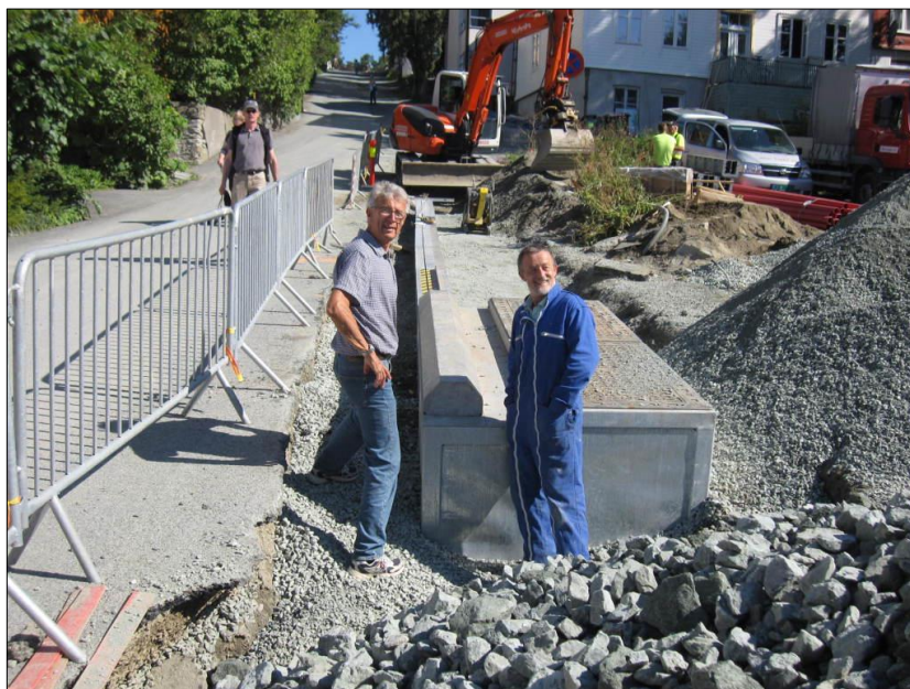
Obrázek 3-4 Jarle Wanvik (vlevo) při výstavbě výtahu [24]
