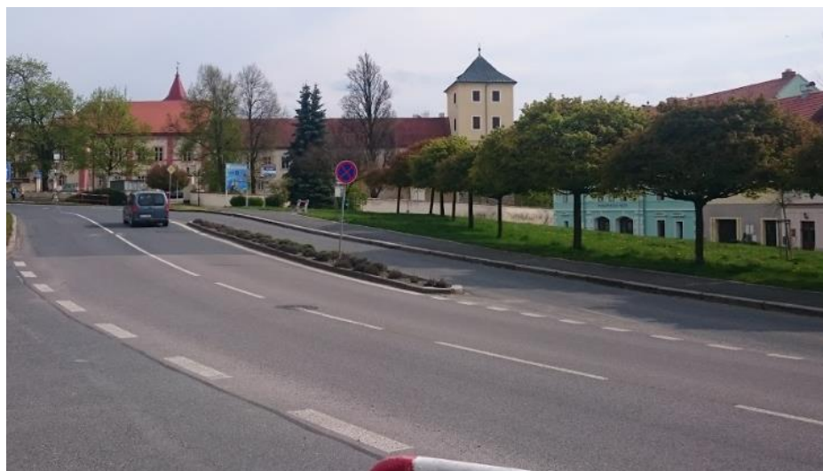
Obr. 41: Provedení zastávky Horažďovice, U Školy ve směru na Strakonice
