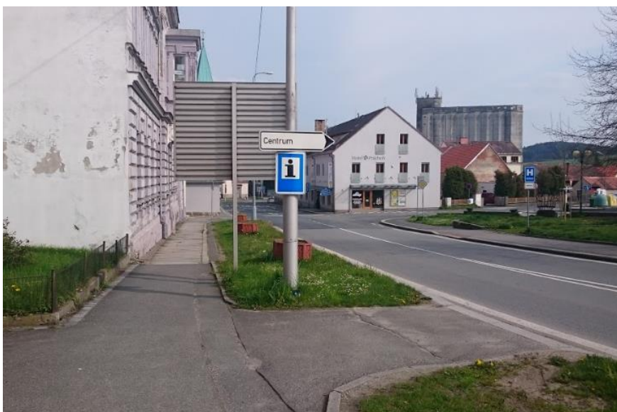
Obr. 50: Pohled na problémové místo sjezdu z příleho objektu
