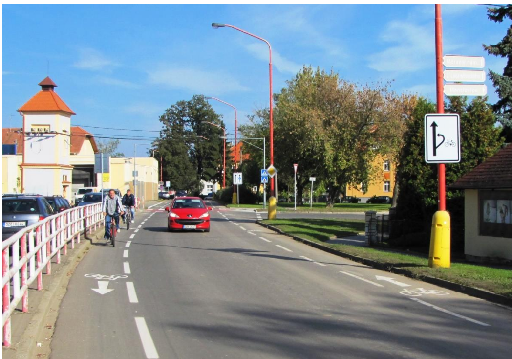
Obr. 78: Víceúčelové pruhy v Uherském Hradišti [zdroj: cyklomesta.cz]
