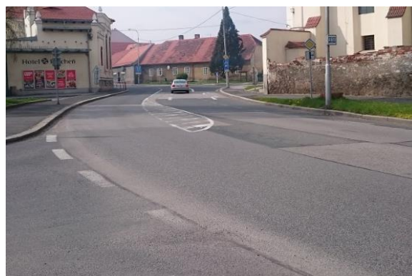
Obr. 59: Opotřebeně VDZ v křiž. u Husova nám.
