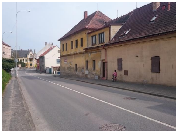
Obr. 29: Pohled na daný úsek z levostranného chodníku ze směru od Klatov
