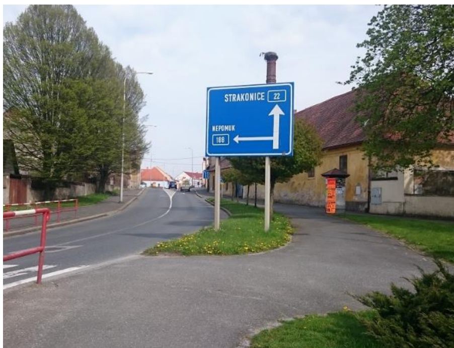
Obr. 43: Nevhodná konstrukce vodorovného značení
