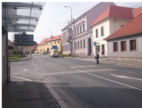
Obr. 51: Opatřené VDZ a důkaz chybějící vazby pro pěší v kř. Strakonická - Příkopy/Ševčíkova
