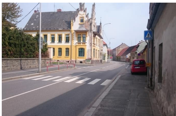
Obr. 24: Přechod pro chodce před základní školou bez prvků OOSPO
