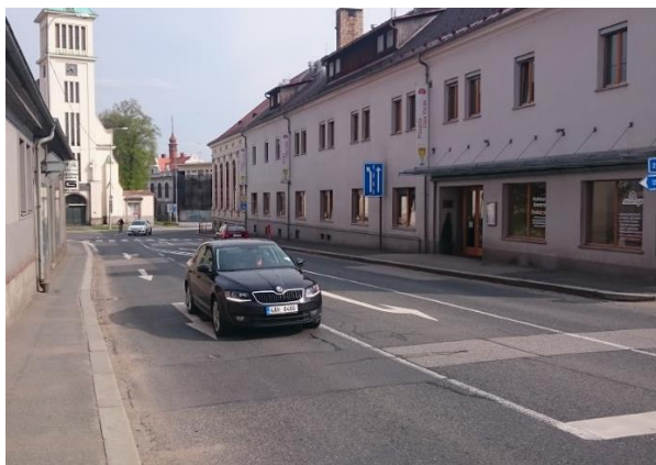
Obr. 55: Pohled na zúžený úsek kom. I/22 před hotelem Prácheň
