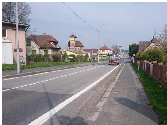
Obr. 27: Zúžený chodník na úkor jízdních pruhů za žel. přejezdem, nevhodně provedená obruba
