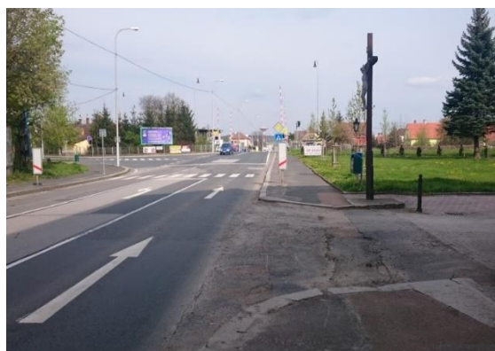
Obr. 25: Chybné vedení chodců přes výjezd z prostoru firmy Keramika Soukup bez prvků pro OOSPO
