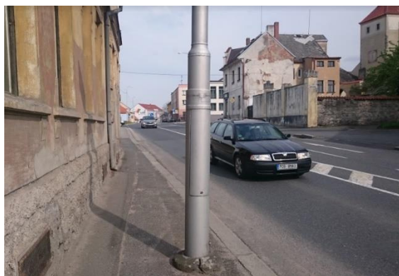
Obr. 22: Nedodržení minimálního průchozího profilu za kř. Strakonická - Plzeňská
