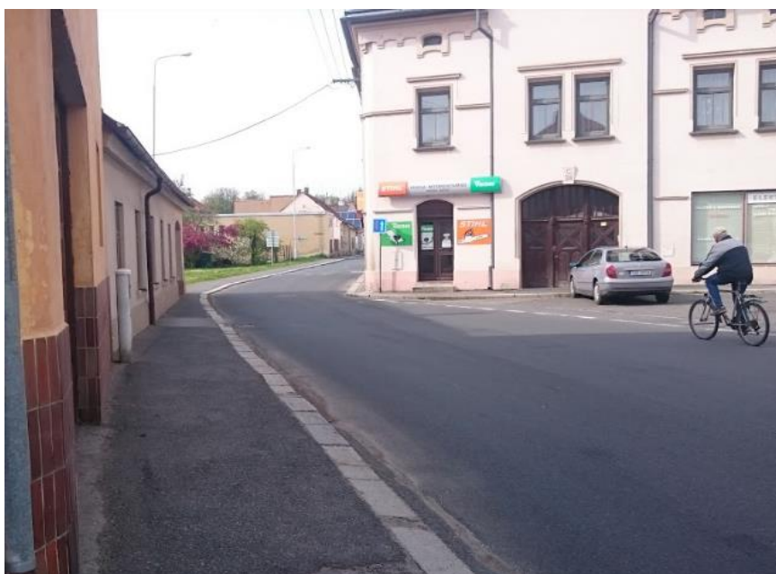
Obr. 48: Pohled na zúžení na Plzeňské ul.
