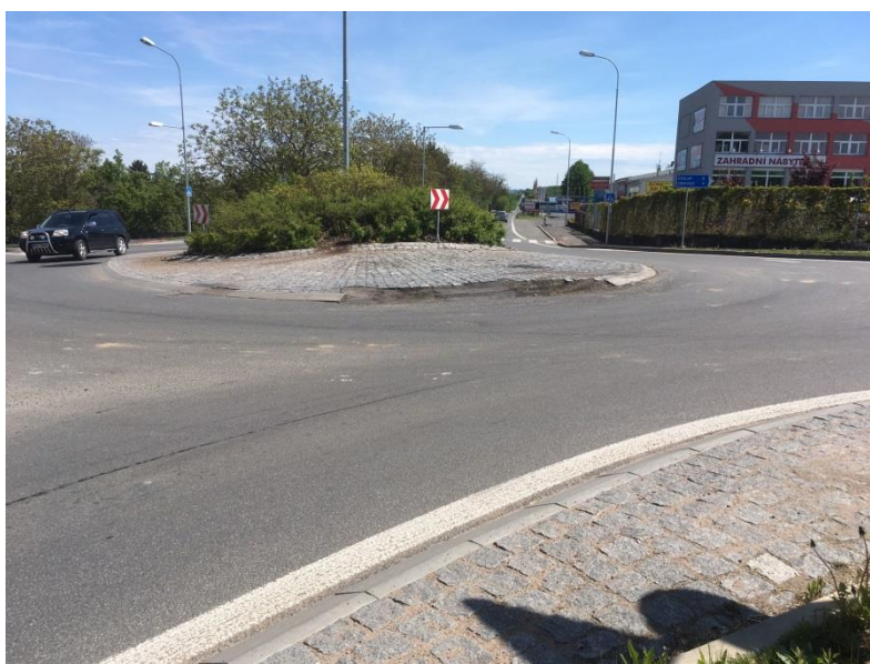
Obr. 8 Poškození středového ostrova
