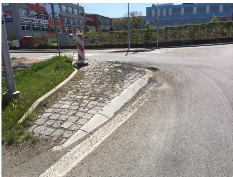
Obr. 9 Poškození srpovité krajnice
