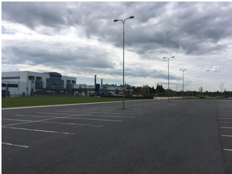
Obr. 10 Průmyslová oblast v jižní části komunikace
