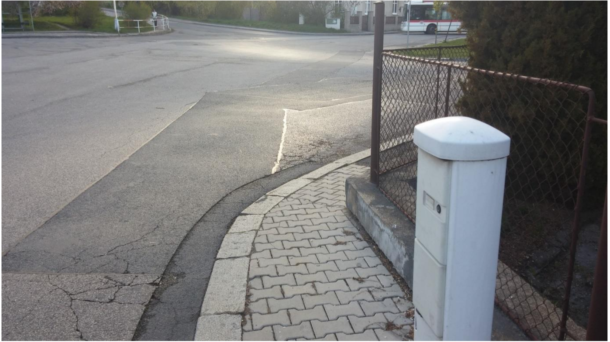
Obrázek 14 - Nedostatečná šířka chodníku na větvi v ulici Klikorkova [autor]
