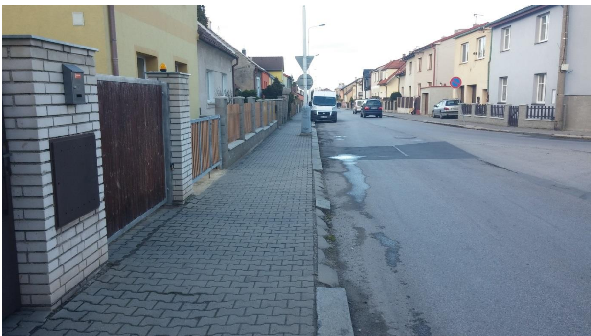
Obrázek 18 - Pozice a stav vjezdů [autor]
