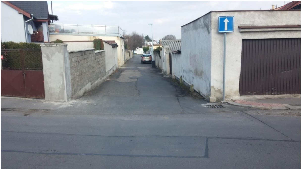
Obrázek 16 - Chybějící přechod/místo pro přecházení v ulici Šachetní [autor]
