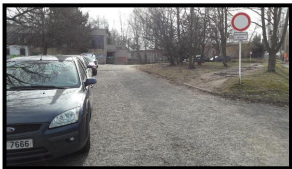
Obrázek 14: Pohled ke kotelně od ulice Žežická
