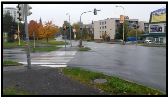
Obrázek 8: Nedostatečné zpracování prvků pro OSSPaO
