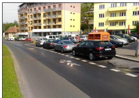
Obrázek 25: Pohled na podélné stání s nevyřešeným odvodem chodců.
