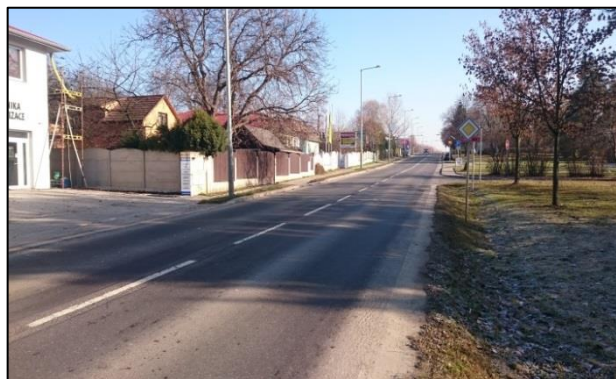
Obrázek 38: Pohled na problémové místo.
