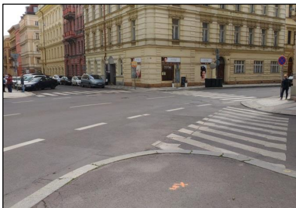
Obrázek 66: Pohled na přechod pro chodce s chybně provedenými prvky pro OsOSP a O.
