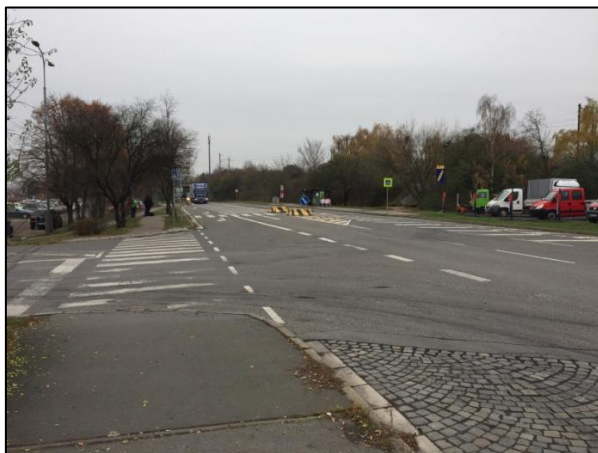
Obrázek 60: Problémový přechod pro chodce u vjezdu do průmyslové zóny.
