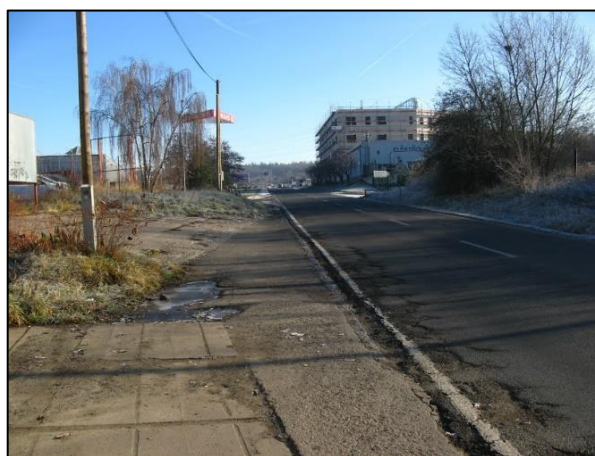
Obrázek 52: Chybějící chodník ve východní části ulice K Ládví.
