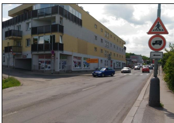
Obrázek 6: Chybějící dopravní značka P2 „Hlavní pozemní komunikace“.
