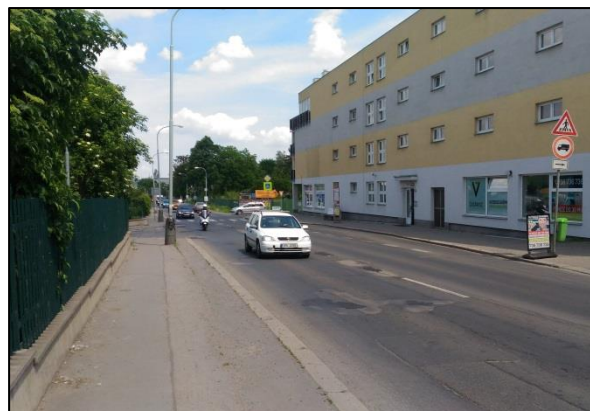
Obrázek 5: Pohled směrem k problémovému přechodu ve směru od Žižkova.
