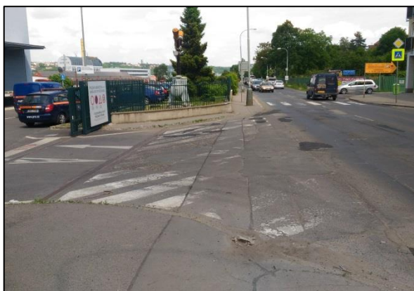
Obrázek 7: Nevhodně řešený výjezd z areálu firmy Pražská energetika, a.s.
