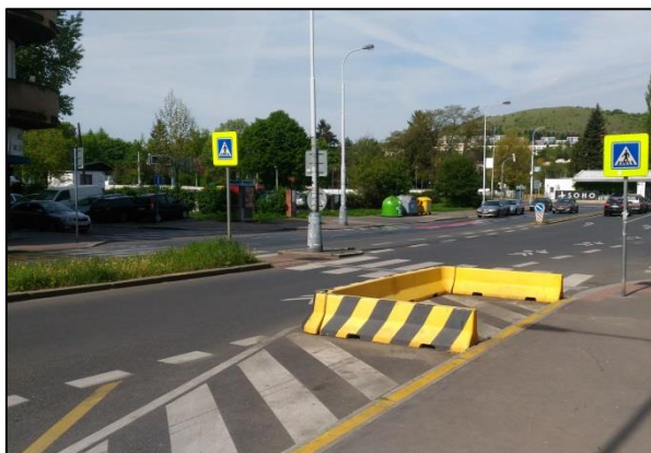
Obrázek 12: Pohled na problémový přechod u křižovatky s ulicí Podolská.
