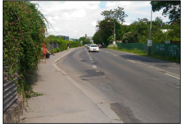
Obrázek 9: Pohled na autobusovou zastávku Odlehlá směr Žižkov.
