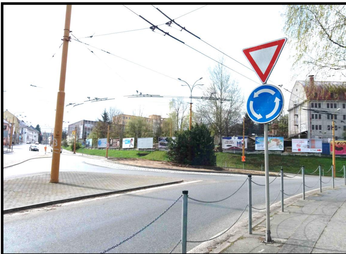
Obrázek 12 - Pohled do OK ulic Havlíčkova a Pražská, z protějšího svahu bude do OK zaústěna nová komunikace, vpravo budova síla
