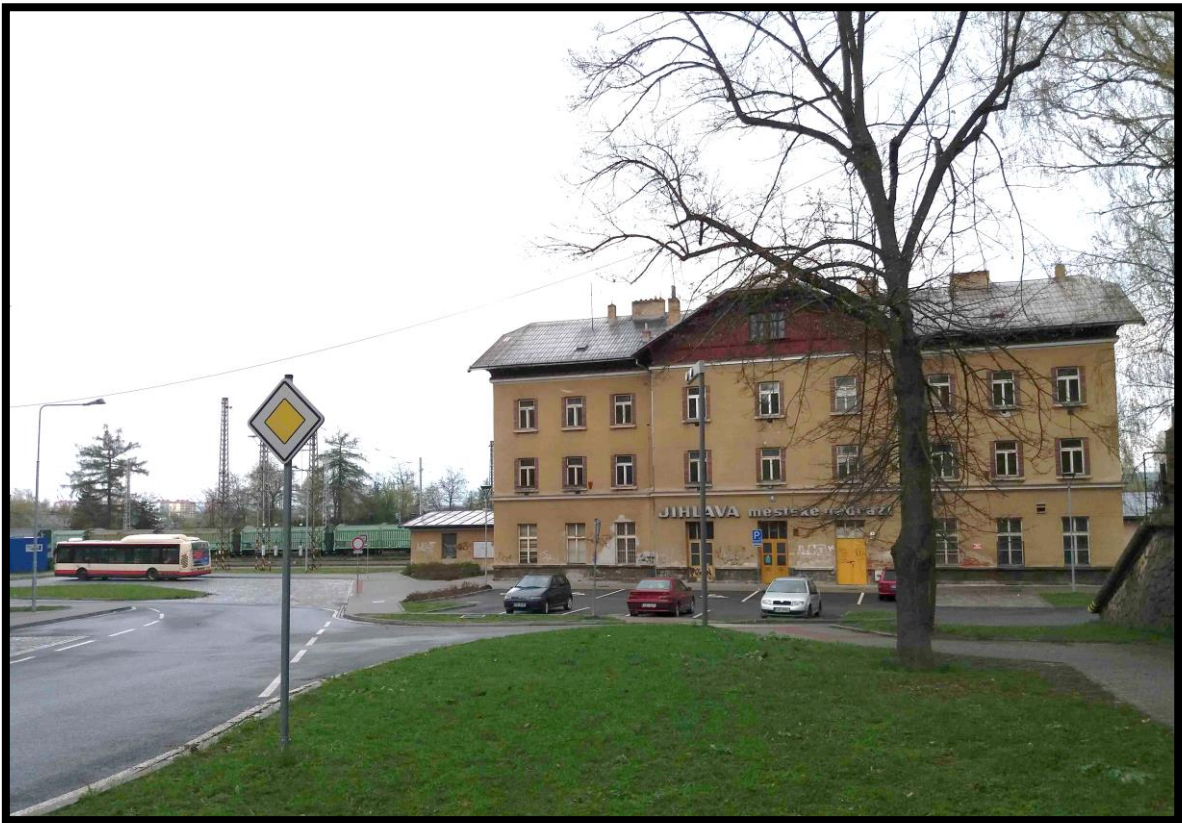
Obrázek 6 - Pohled na výpravní budovu
