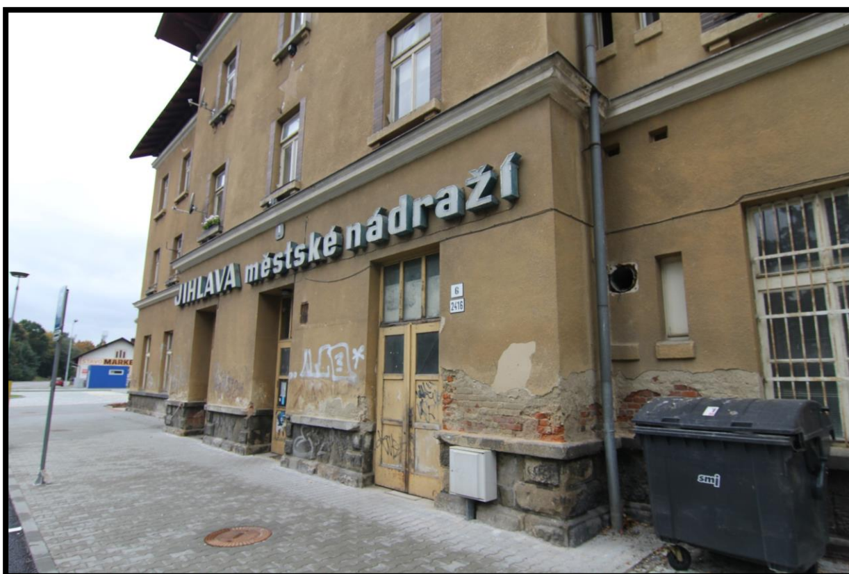
Obrázek 22 – Současný stav výpravní budovy železniční stanice Jihlava město [07]
