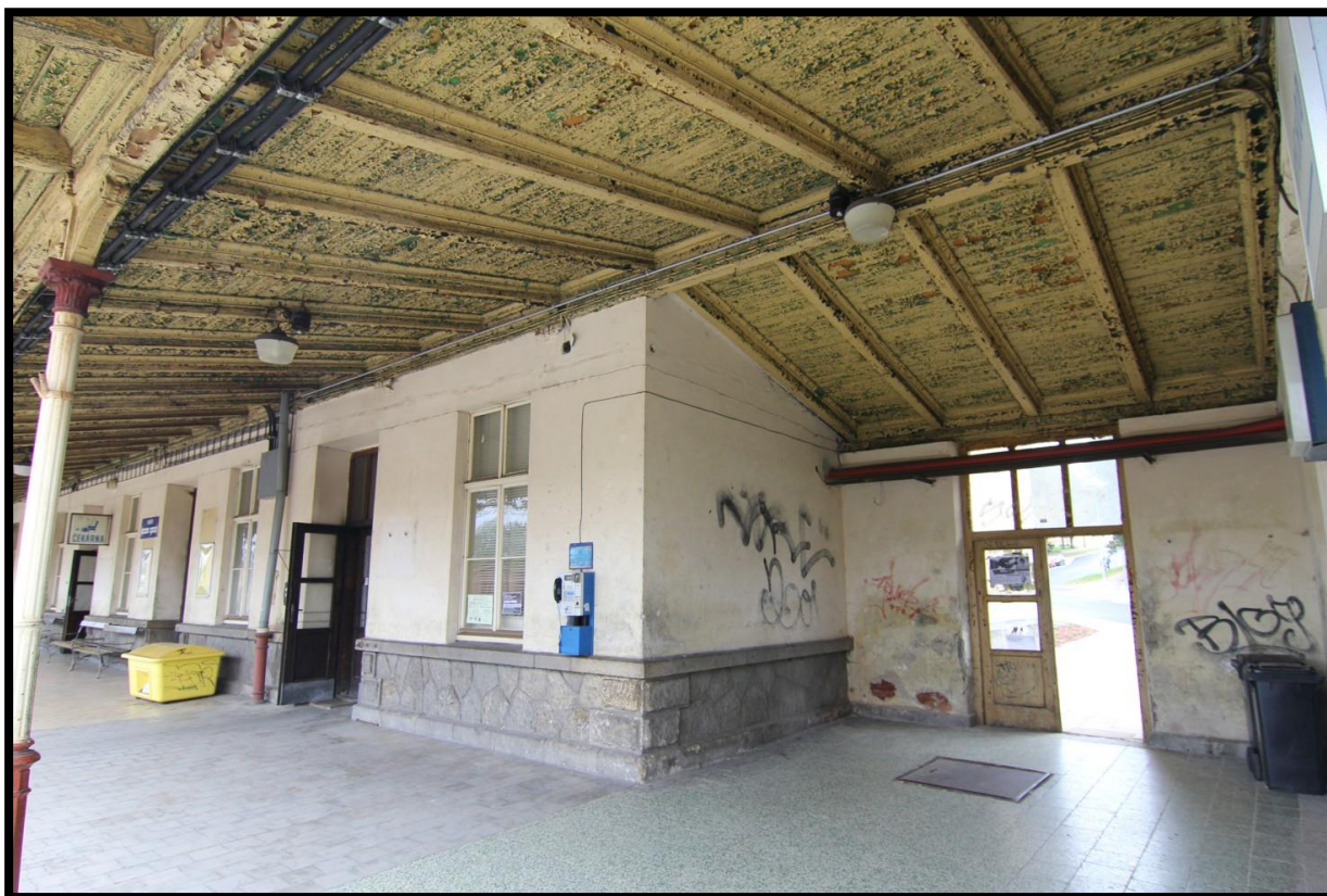
Obrázek 23 – Současný stav výpravní budovy železniční stanice Jihlava město [07]
