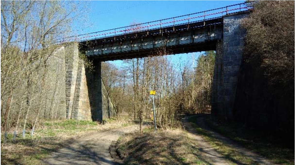
Obrázek 20: železniční viadukt u Podhrážského mlýna
