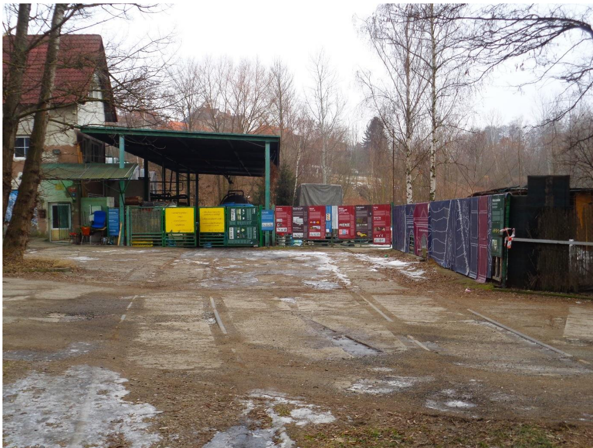
Obrázek 7 - Vlečkové kolejiště teplárny. Pouze levá kolej v místě nádrže s mazutem je přerušena [zdroj: autor, 2017]
