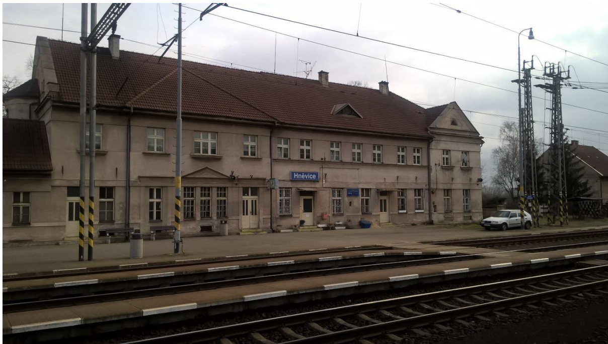
Obrázek 7 - ŽST Hněvice obsazená staničním dozorcem, foto: autor, 2017
