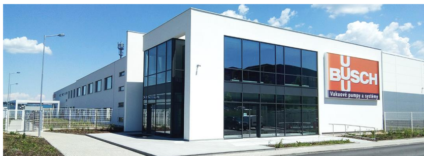
Obrázek 9 Budova Busch VÝROBA CZ, s.r.o. v liberecké průmyslové zóně Sever Zdroj: Vakuové pumpy a systémy, 2017, online
