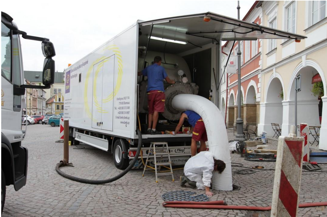
Obrázek 9: Obnova kanalizačního potrubí inverzním rukávcovým reliningem
