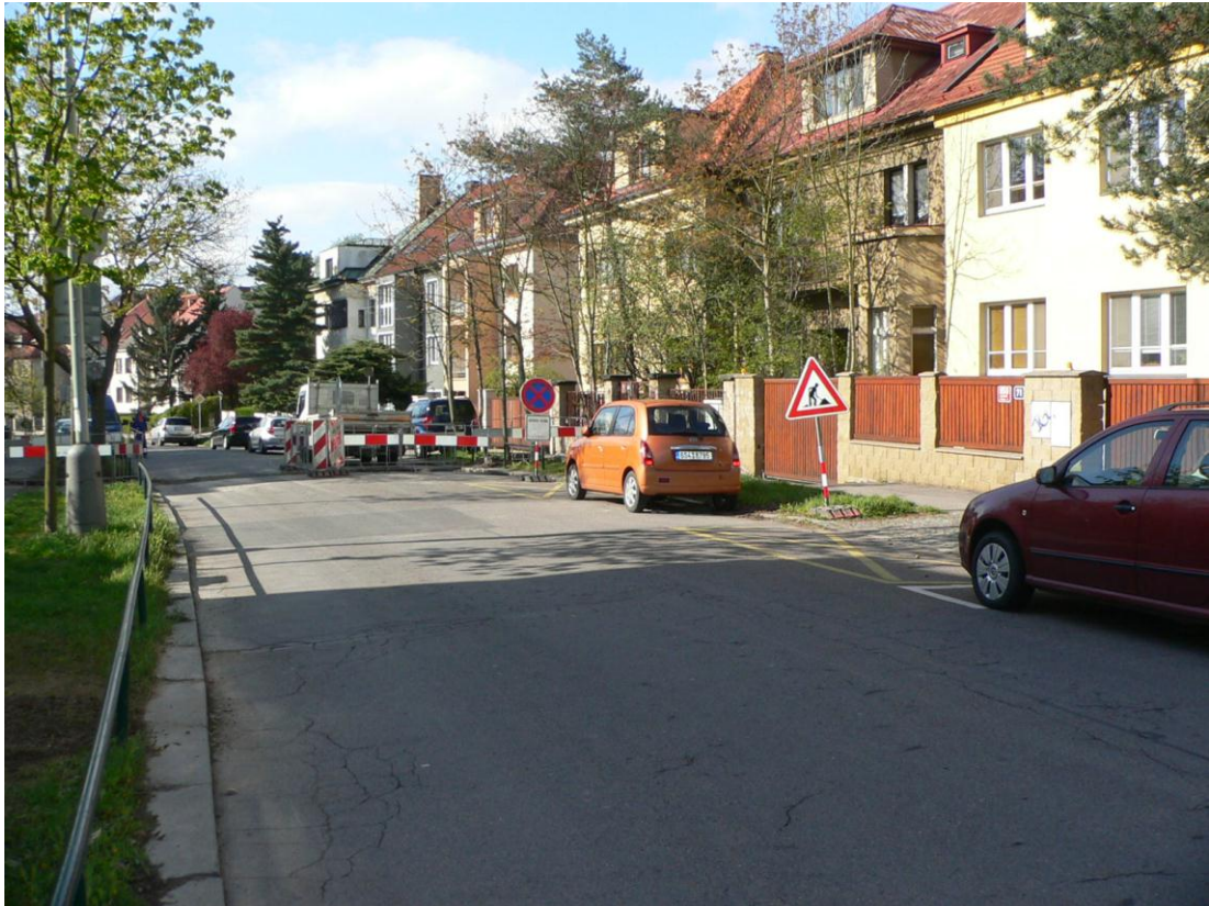
Šárecká ulice, Praha 6 (v blízkosti ul. Na pískách)
