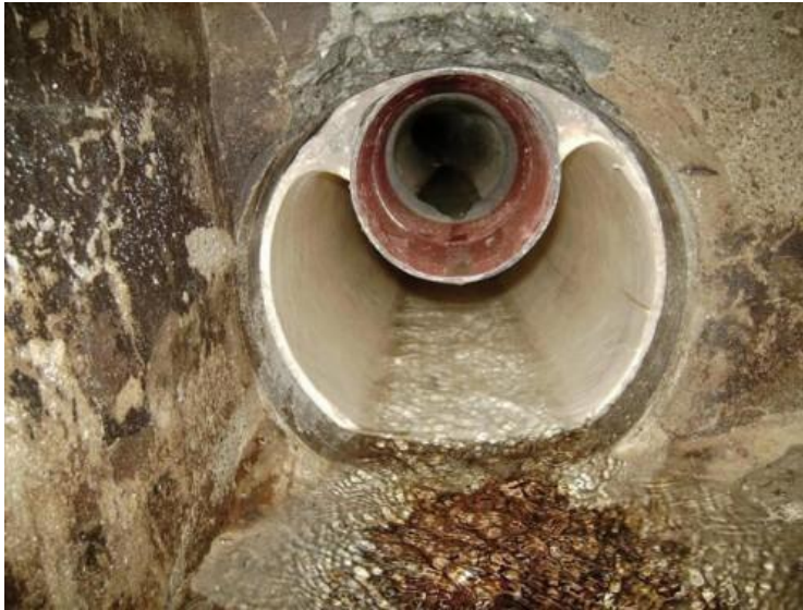
Obrázek 10: Specifický rukávcový relining „dva v jednom“ Zdroj: [10]
