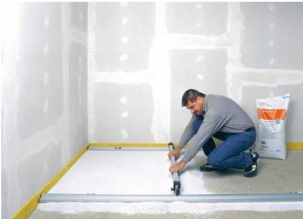
Obrázek 3: Srovnání podkladu vyrovnávacím podsypem fermacell
