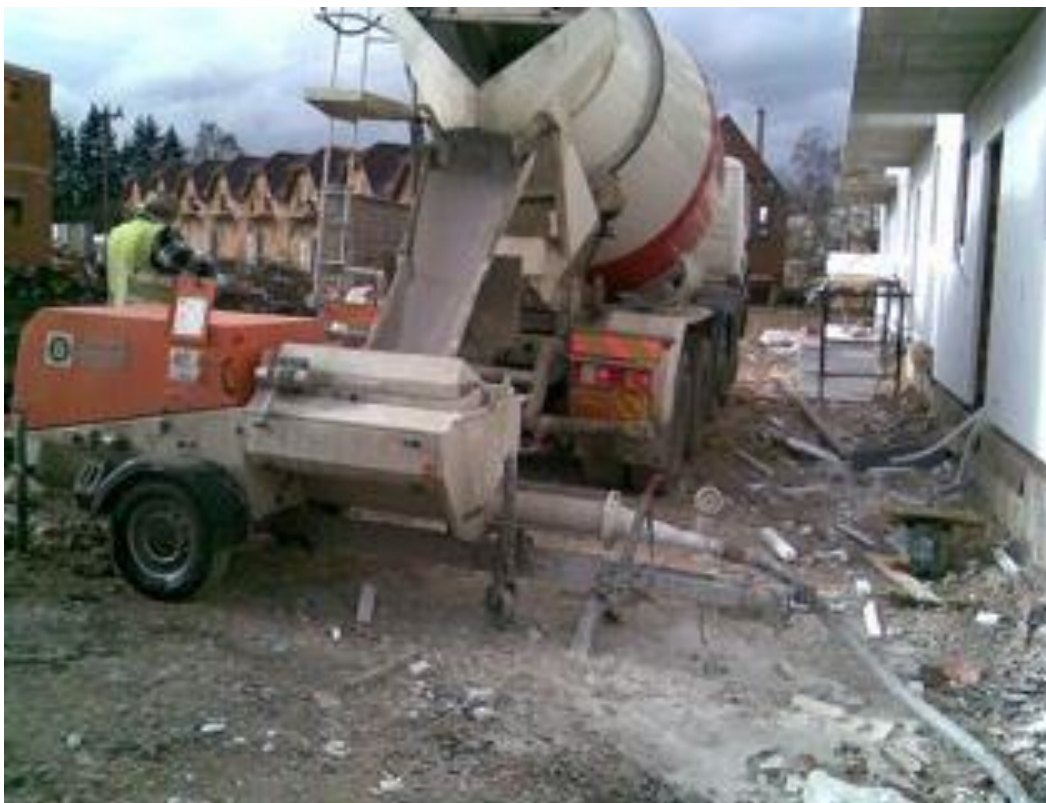
Obrázek 10: Doprava litého anhydritu na stavbě (18)
