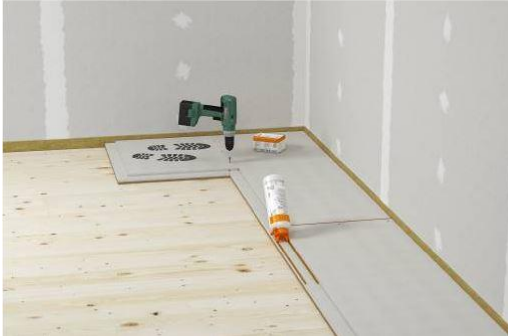
Obrázek 2: Lepení a šroubování suché podlahy fermacell
