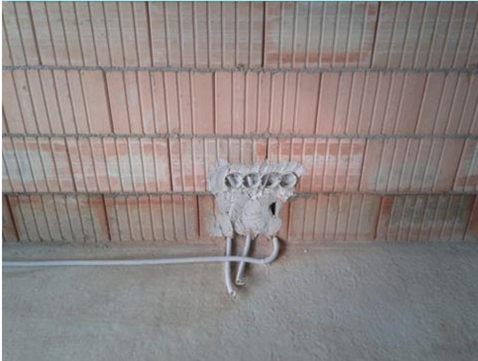
Obrázek 8: Elektrorozvody a krabičky pro zásuvky v neomítnuté stěně (15)
