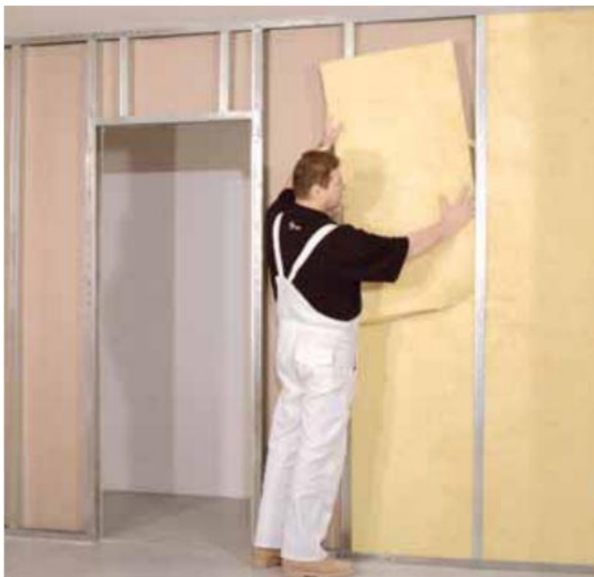
Obrázek 4: Vkládání minerální izolace do dutiny příčky (8)
