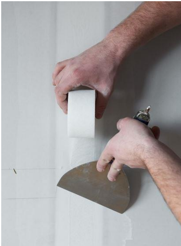
Obrázek 6: Vtlačení pásky do tmelené spáry (9)
