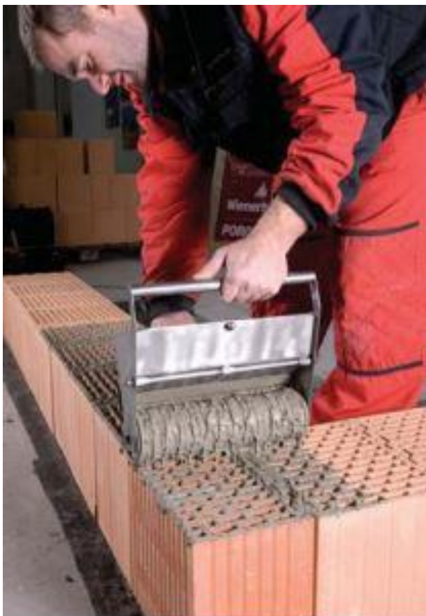
Obrázek 9: Nanášení malty pro tenké spáry válcem (14)
