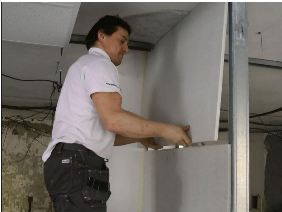
Obrázek 1: Montáž stěny s deskami fermacell na kovovou konstrukci
