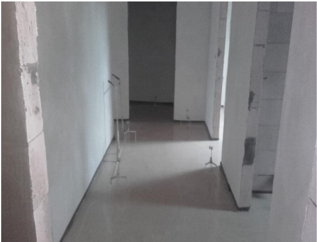
Obrázek 12: Čerstvě vylitý anhydrit (18)
