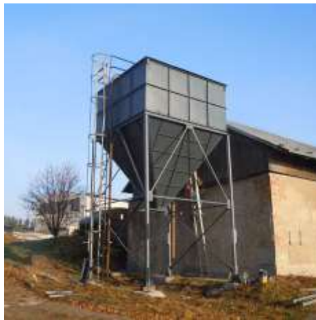
Obrázek 1 Ocelový zásobník – násypka [4]
