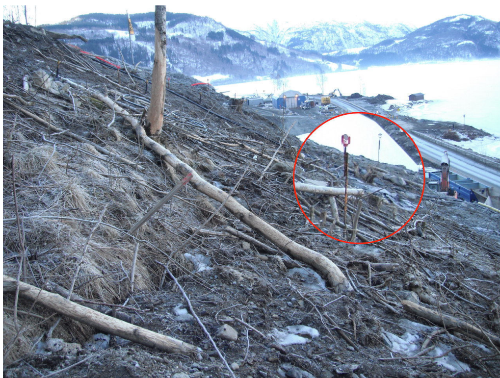
Obr. 42 Geodetické body měřící deformace terénu nad tunelem
