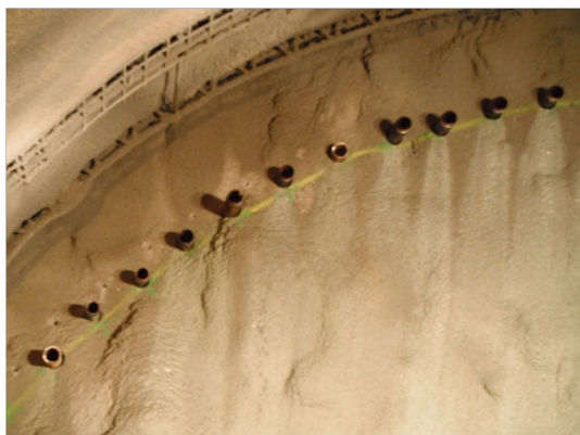
Obr. 14 Výpažnice mikropilotového deštníku
