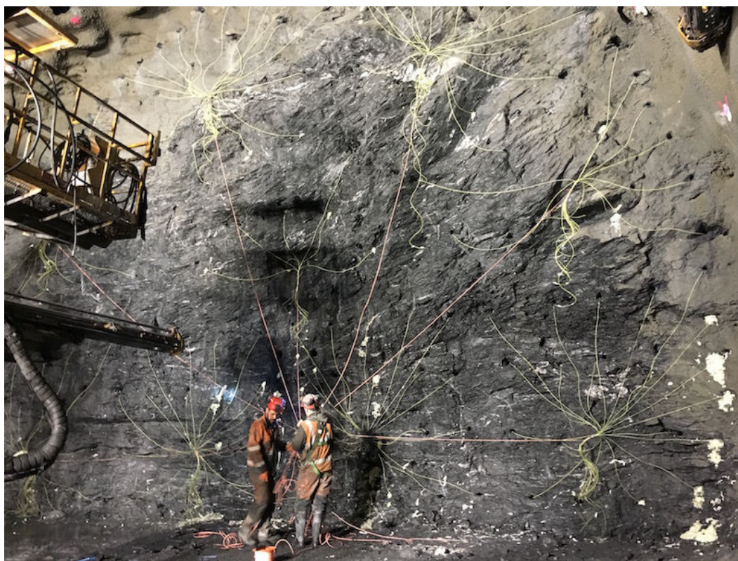
Obr. 9 Svazování bleskovice a příprava na odpal
