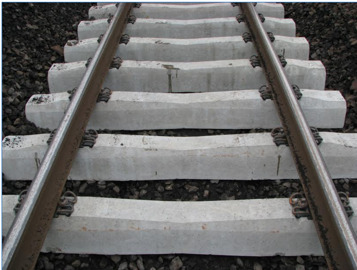
Obrázek 60 - Vysokorychlostní prážec BC 12 v koleji před zaštěrkováním
