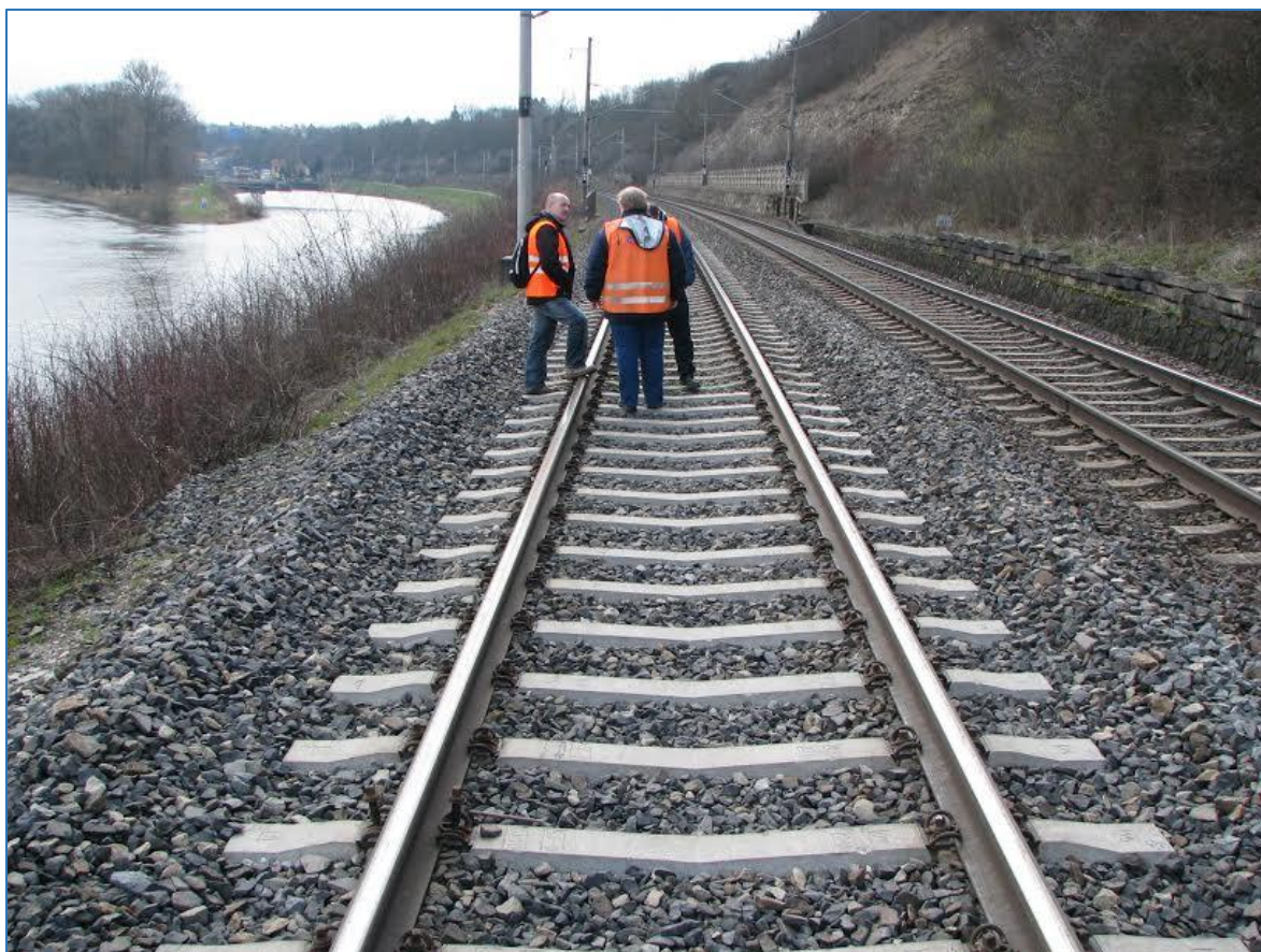
Obrázek 61 - Vysokorychlostní prážec v koleji
