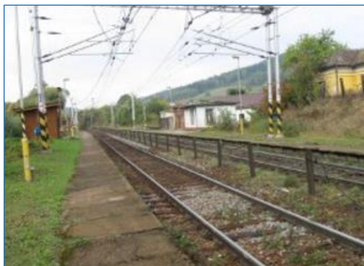
Obrázek 79 - Pohled na zastávku Střelná nedaleko Střelenského tunelu [52]
