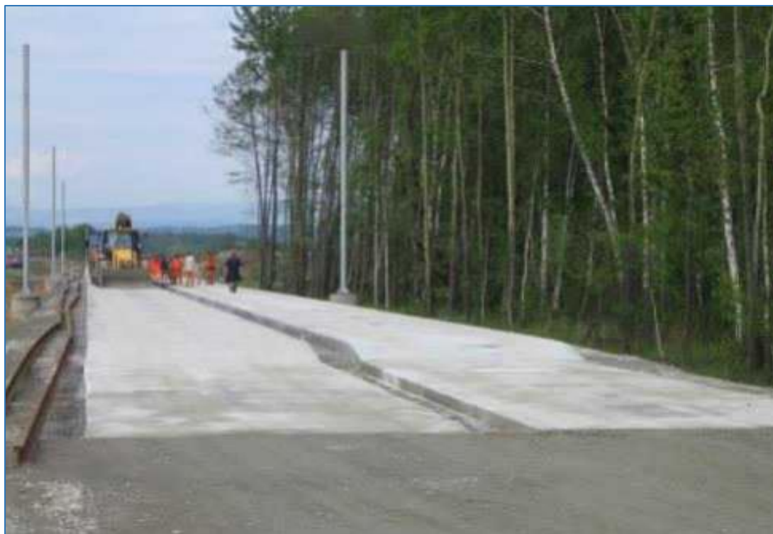
Obrázek 68 - Přechodová oblast železničního spodku PJD systému RHEDA 2000 [31]
