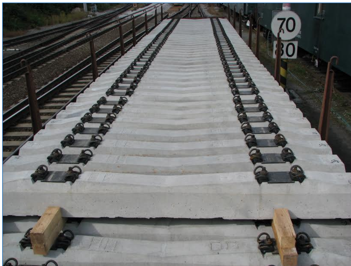
Obrázek 59 - Vysokorychlostní pražec BC 12 připraven na vložení do koleje
