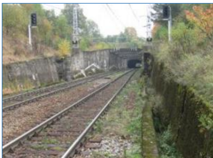
Obrázek 78 - Pohled na předportálí Střelenského tunelu před rekonstrukcí [52]
