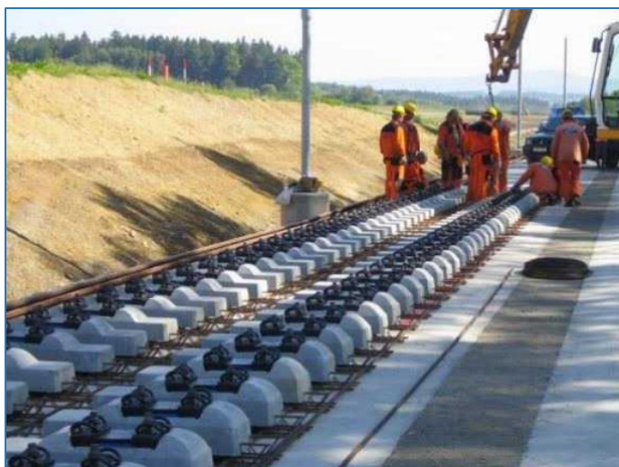
Obrázek 75 - Stav konstrukce PJD před zmonolitněním [31]
