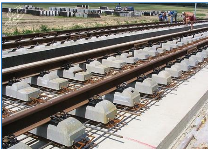
Obrázek 74 - Stav konstrukce PJD před zmonolitněním [51]
