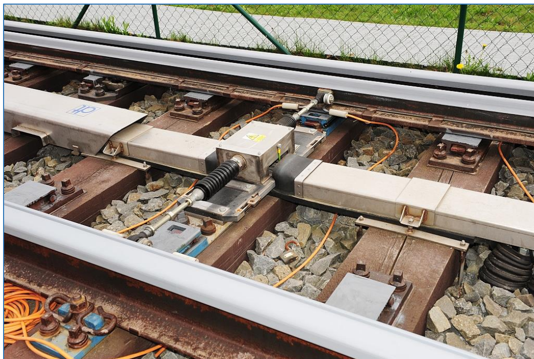
Obrázek 40 - Snímač polohy jazyka výhybky 1:33,5-8000/4000/14000 [44]
