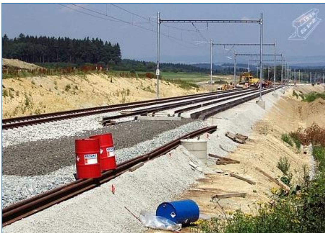
Obrázek 67 - Pohled na stabilizovanou část kolejového lože [51]
