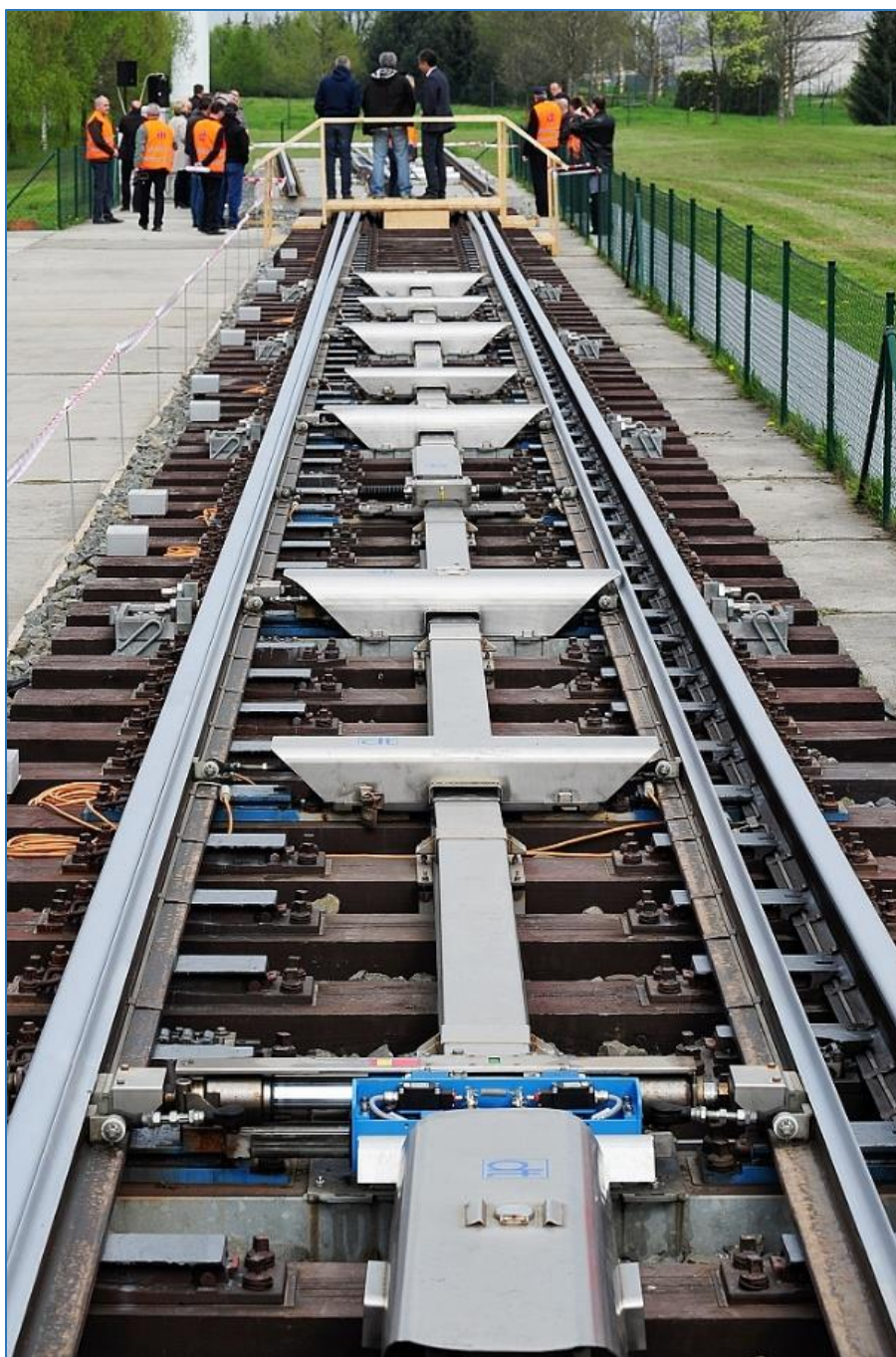
Obrázek 39 - Výměnová část výhybky 1:33,5-8000/4000/14000 [44]
