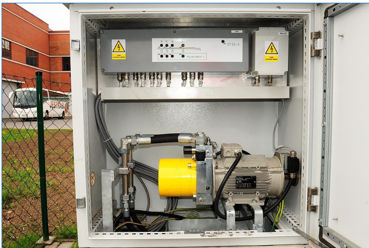
Obrázek 42 - Skříň s hydraulickým pohonem výhybky [44]
