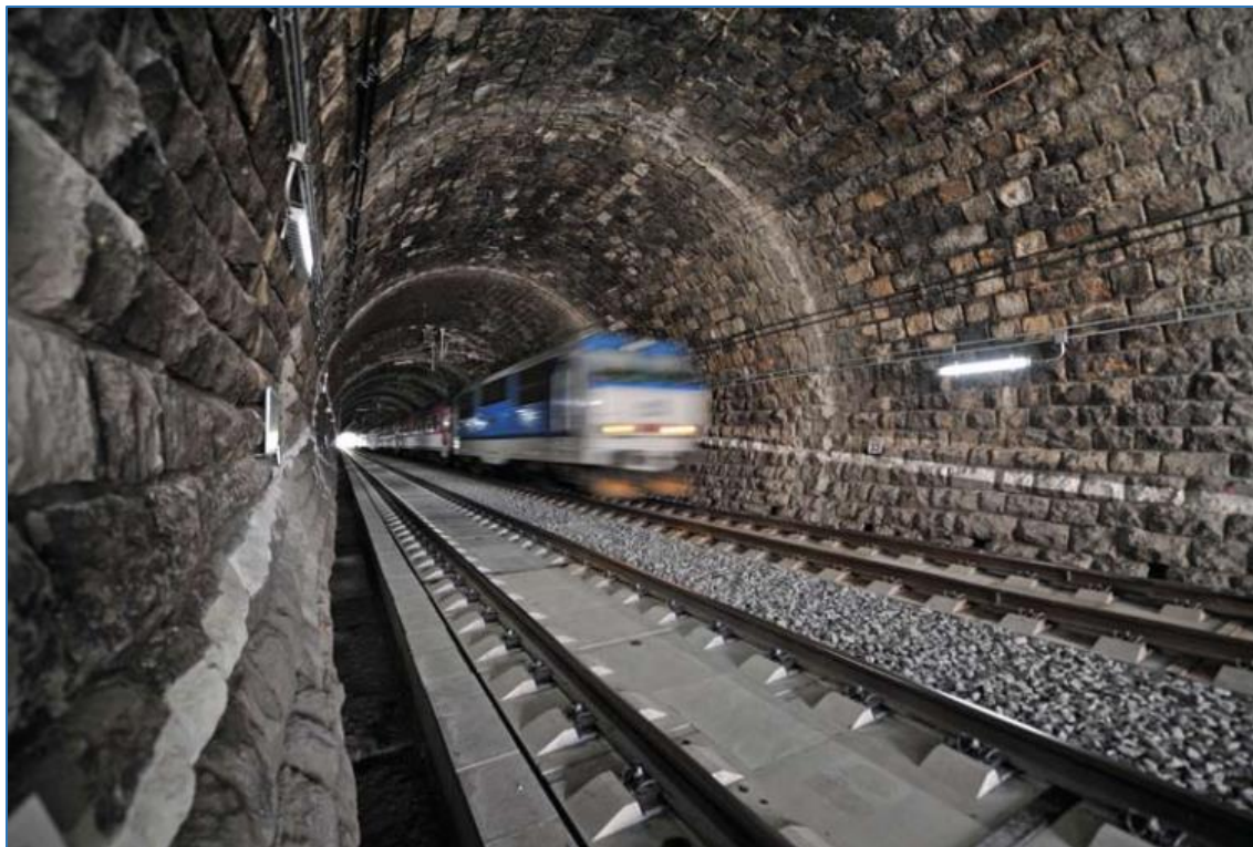
Obrázek 83 - Pohled na zrekonstruované koleje Střelenského tunelu [55]
