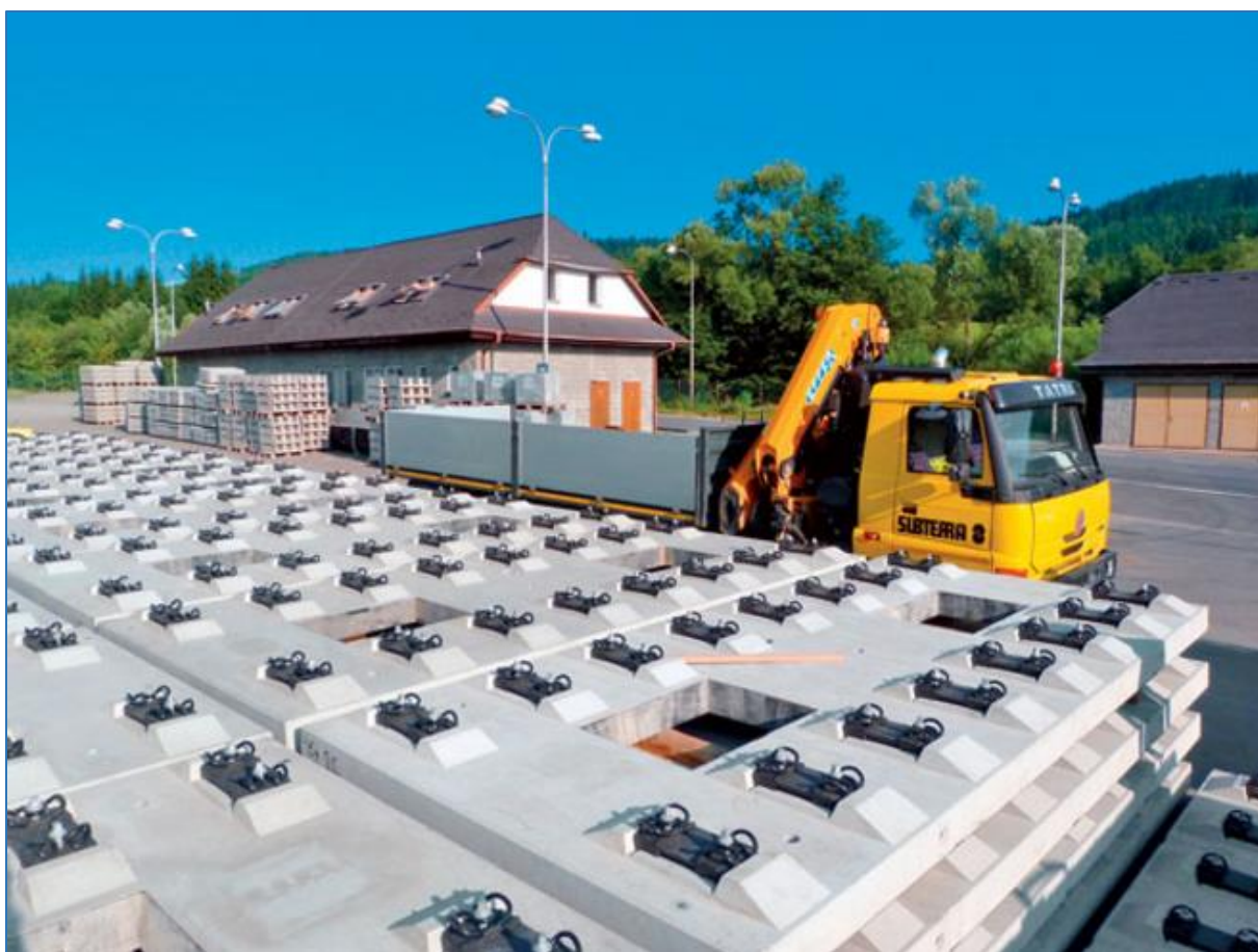
Obrázek 82 - Nosná železobetonová deska systému ÖBB Porr na skládce [53]
