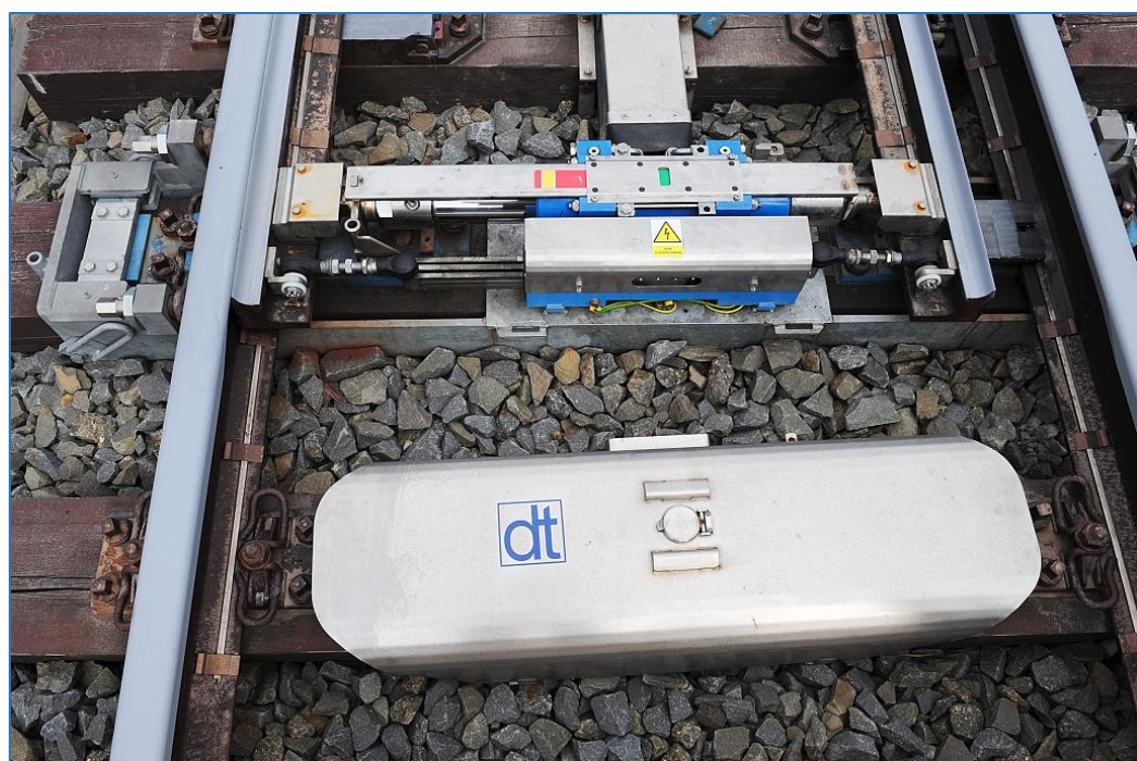
Obrázek 41 - Výměnový závěr výhybky 1:33,5-8000/4000/14000 [44]
