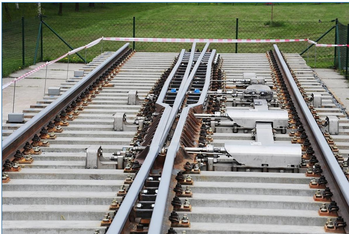
Obrázek 43 - Srdcovková část výhybky 1:33,5-8000/4000/14000 [44]
