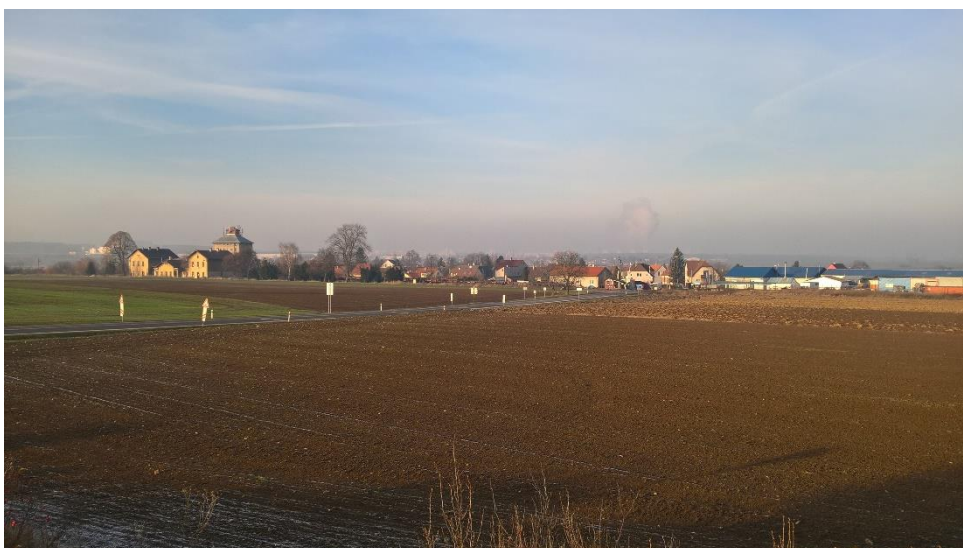
Obrázek 5 - stávající silnice I/61 v místě křížení s železniční tratí
