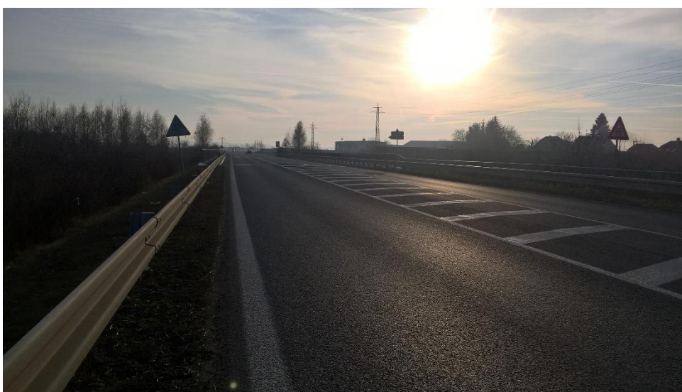
Obrázek 3 - stávající most v MÚK Fialka ve směru na Unhošť
