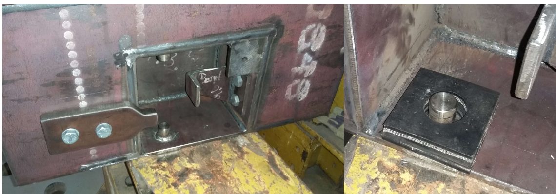
Obr. 36: Vlevo prázdná krabice, vpravo úložný elastomerový blok nasazený na nerezovém čepu v dolní části krabice
