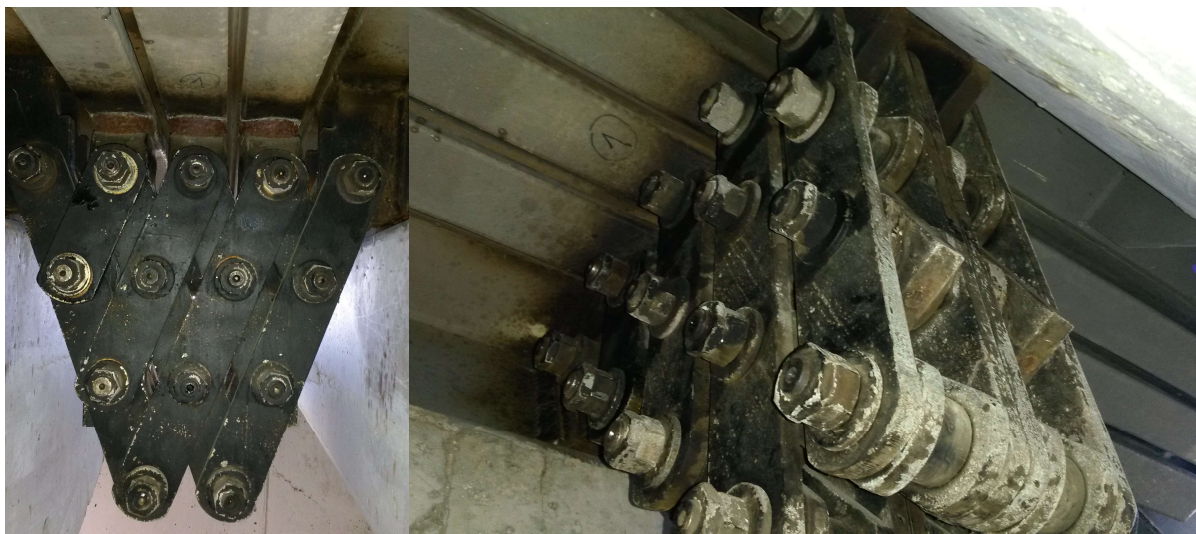
Obr. 19: Nůžkový mechanismus na mostě v Ejpovicích
