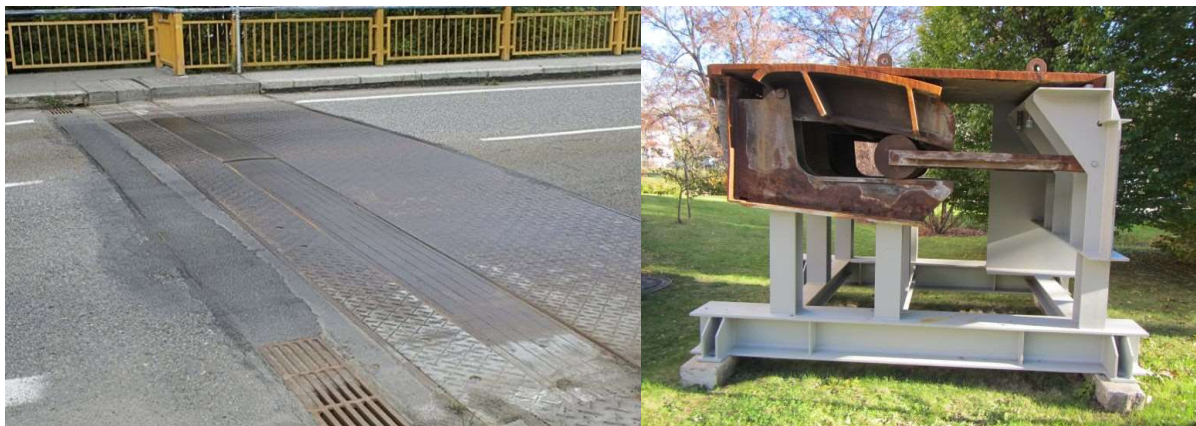
Obr. 12: Vlevo pohled shora [8], vpravo vystavený segment podporovaného MZ (oboje Žďákovský most)
