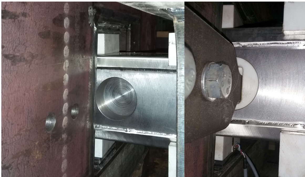
Obr. 39: Vlevo traverza ještě nezafixovaná proti posunům, vpravo již zafixovaná pomocí zádržného plechu v zedexovém čepu, čep je osazený do otvoru v traverze
