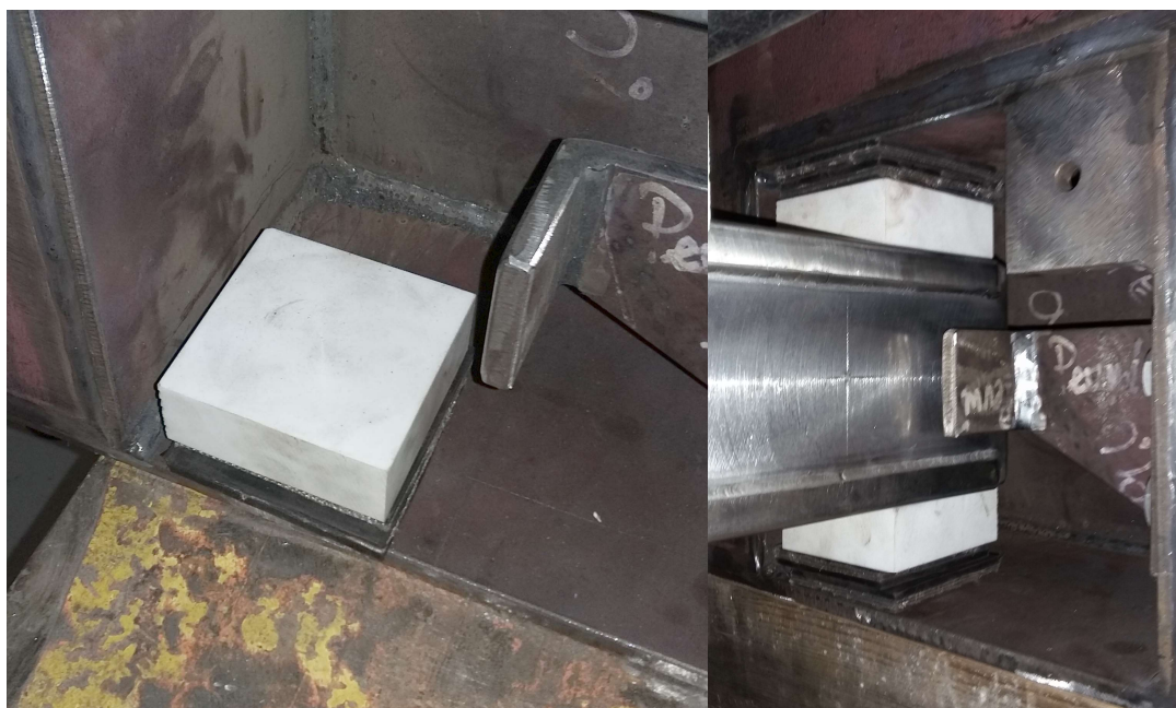
Obr. 37: Vlevo úložný kluzný blok na úložném bloku, vpravo sestavené celé uložení traverzy v pevné krabici, v horní části opět úložný a kluzný blok na nerezovém čepu, na boku elastomerový bloček uchycený speciálním přípravkem
