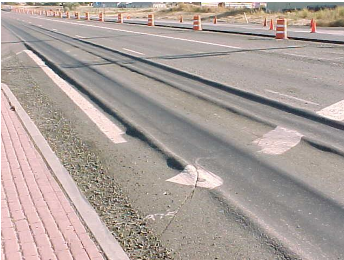
Obr. 32: Vyjeté koleje v předpolí křižovatky [113]
