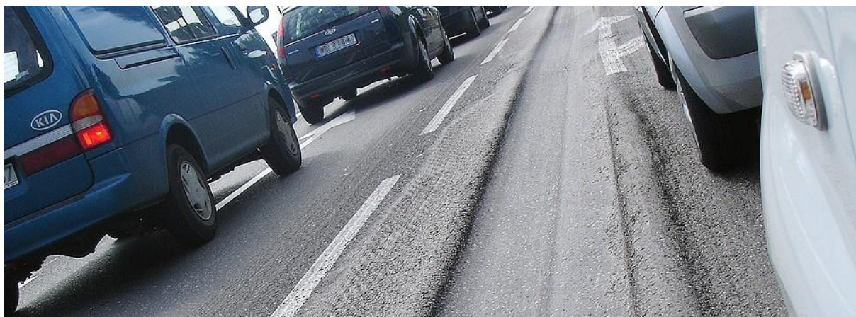
Obr. 31: Vyjeté koleje v řadicím pruhu [112]
