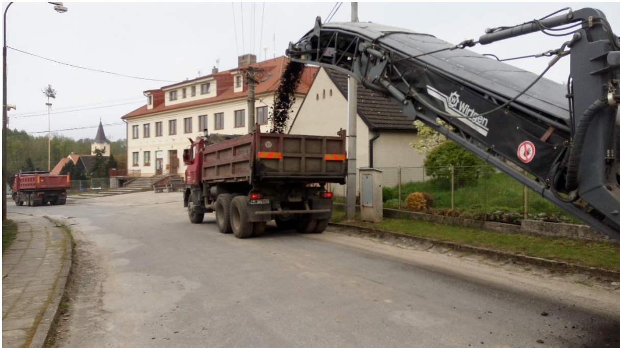
Obr. č.10: Nakládání vyfrézovaného materiálu (oprava silnice III/1553 – průtah obcí Ponědraž)
