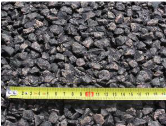
Obr. č.8: Detail drenážního koberce v řádném stavu [22]
