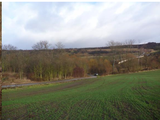
Foto 18 - profil hráze z levého břehu
