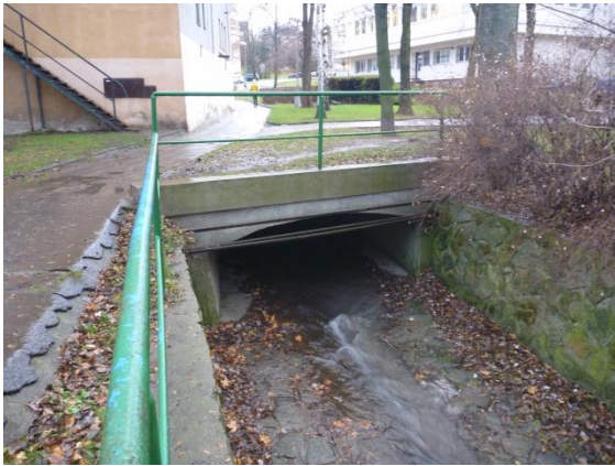
Foto 7 - výtok z uzavřeného profilu
