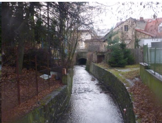
Foto 6 - nátok do uzavřeného profilu
