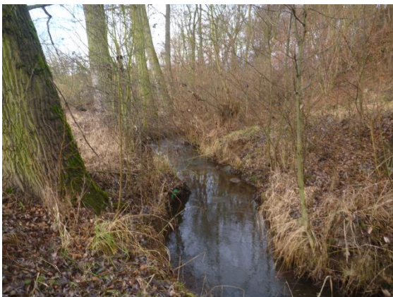
Foto 17 - Syčivka v profilu hráze
