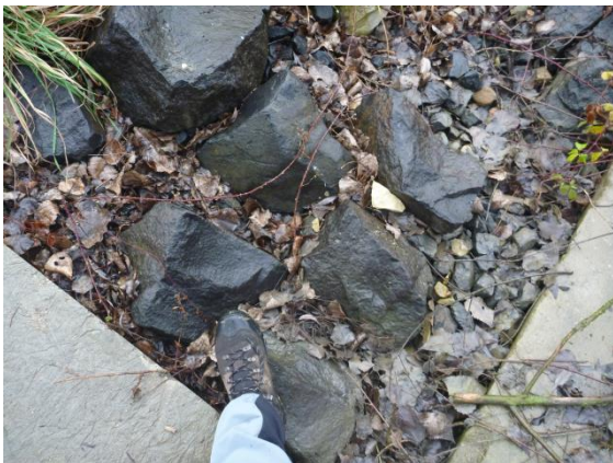
Foto 11 - opevnění přítoku z výsypky
