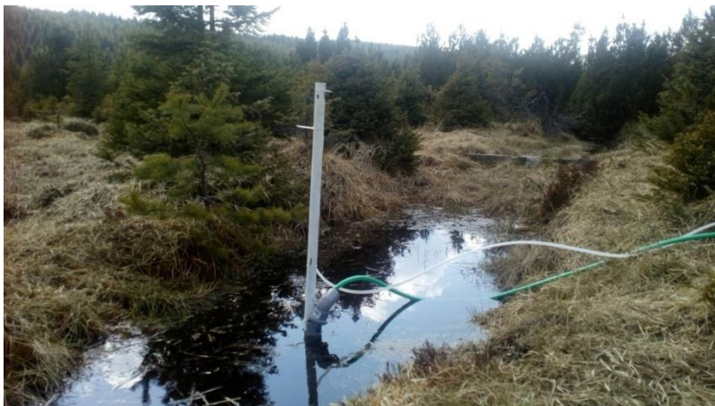
Obrázek 13-12 - Instalace hladinového čidla do příkopu
