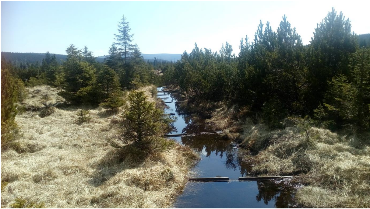
Obrázek 13-2 - Příkop v roce 2016 po osazení přehrážek
