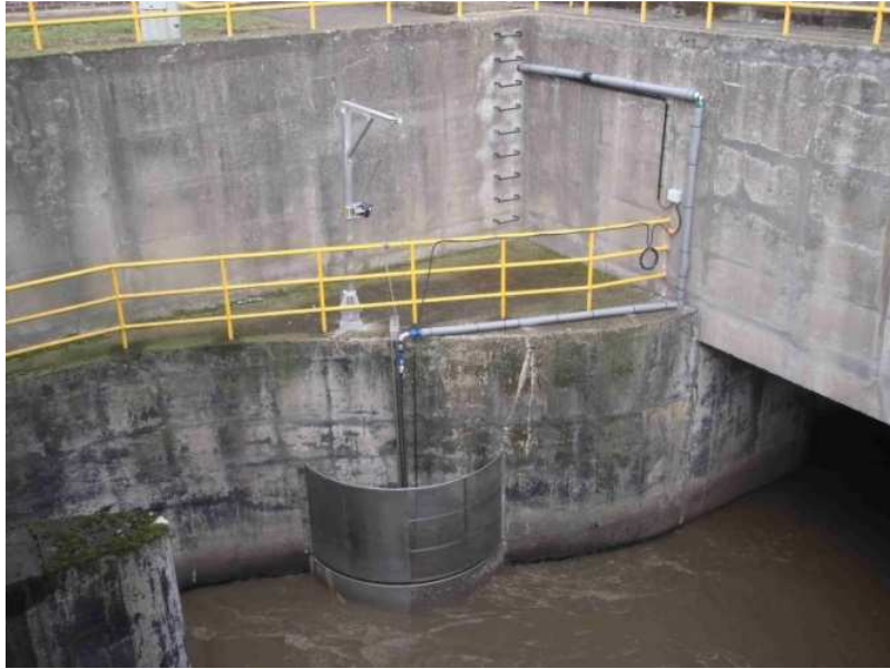
Obr. 4.3 - Umístění ponorného kalového čerpadla s ochranným košem
