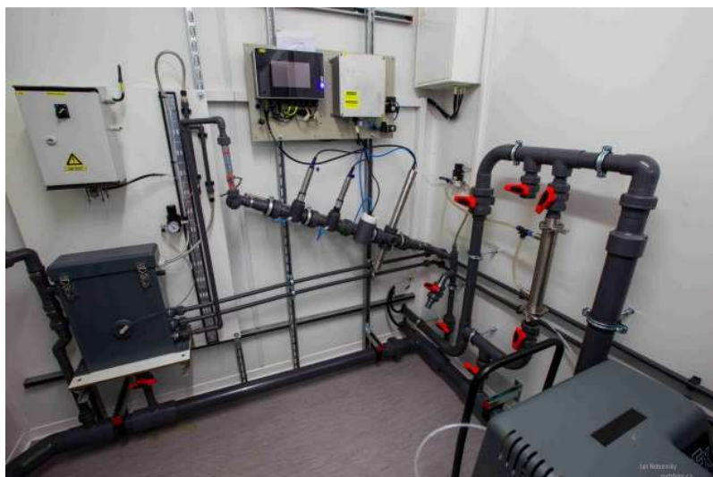
Obr. 4.4 – Rozmístění ponorných sond a senzorů, retenční nádoby s mikrofiltrem a tangenciálního filtru
