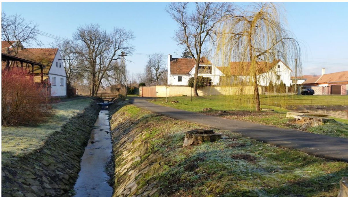
Obr. č.3: Opevněné koryto vodního toku vedle nádrže
