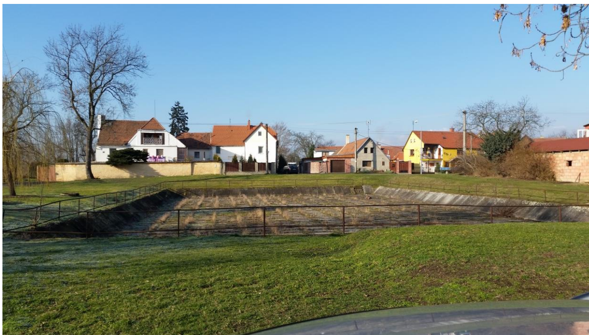
Obr. č.1: Pohled na návesní nádrž směrem od silnice
