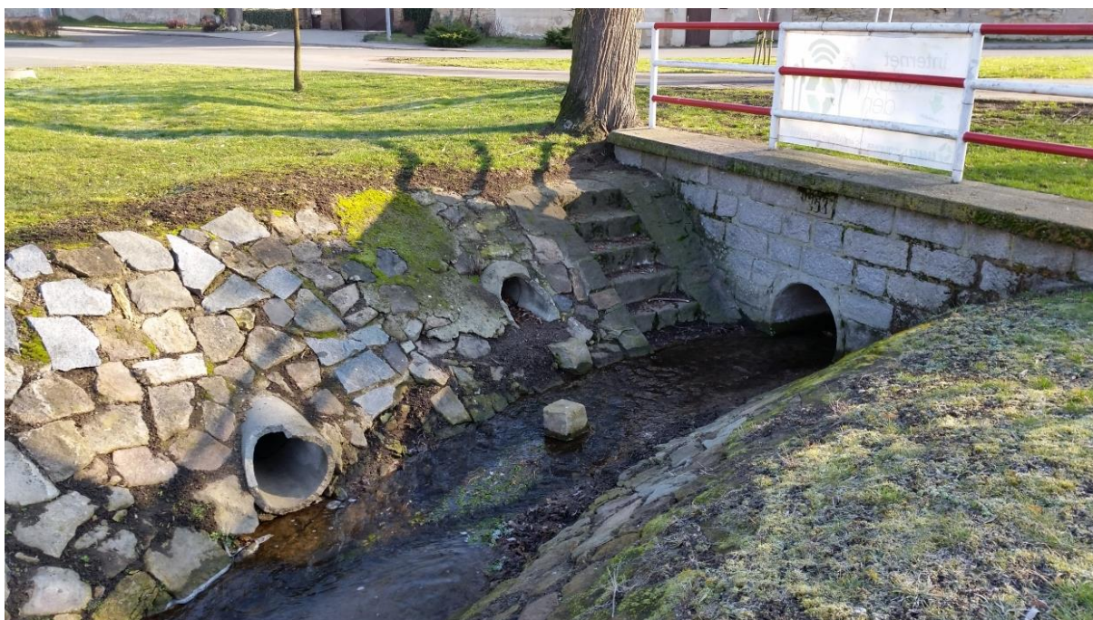
Obr. č.4: Vyústění potrubí vodního toku (otvor vpravo), vyústění potrubí dešťové kanalizace (otvor uprostřed), vyústění potrubí toku jdoucího ze severu (otvor vlevo)
