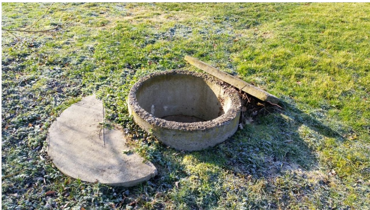
Obr. č.7: Šachta vypouštěcího zařízení nádrže
