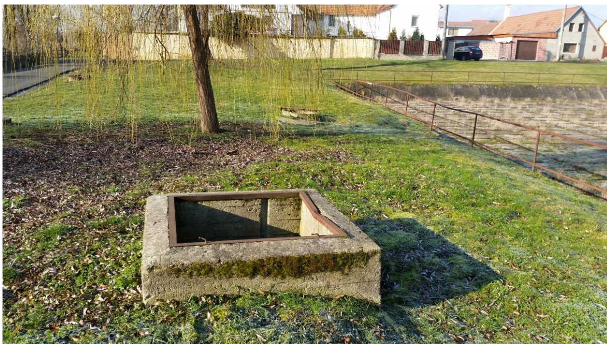
Obr. č.6: Šachta bezpečnostního přelivu nádrže
