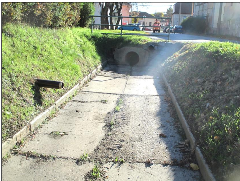
Obr. 23 - Vyústění dešťové kanalizace a odtoku z krytého žlábků do otevřeného příkopu
