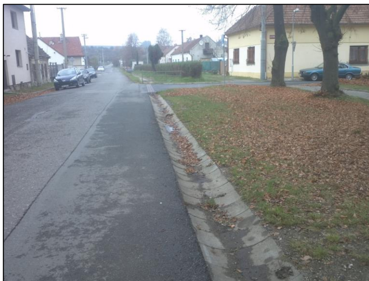
Obr. 21 - Betonové žlabovky v ulici 9.Května
