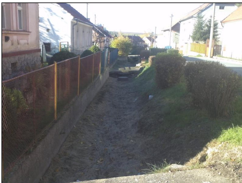
Obr. 18 - Otevřený příkop v ulici Pod Špičákem
