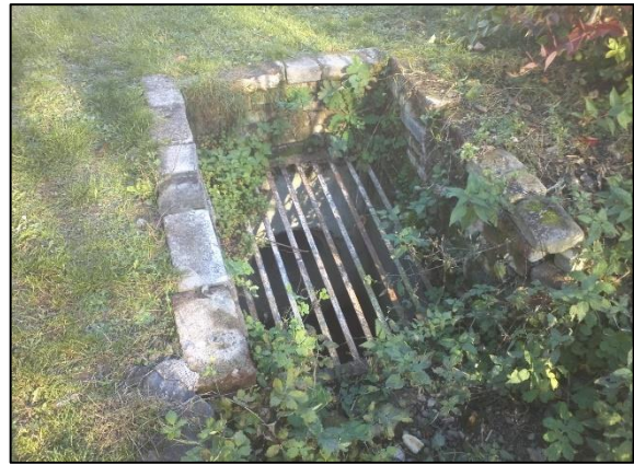
Obr. 2 - Horská vpust na výstupu ze sprášové rokle s odtokovým potrubím DN 400
