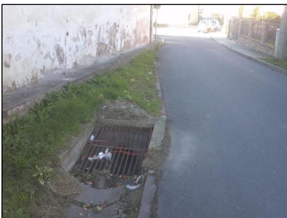
Obr. 5 - Horská vpust s odtokovým potrubím DN 400 v ulici Pod Špičákem
