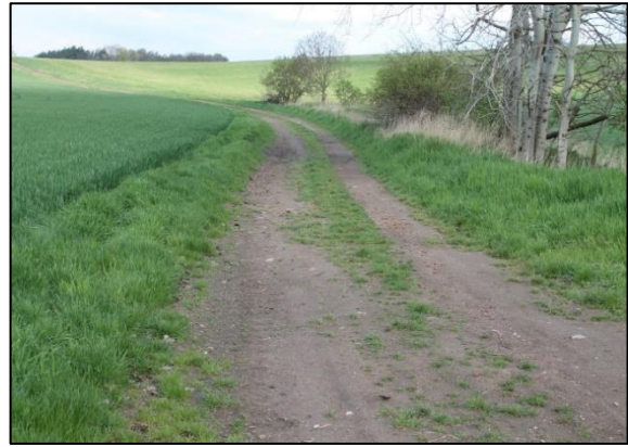
Obr. 8 - Částečně zpevněná polní cesta
