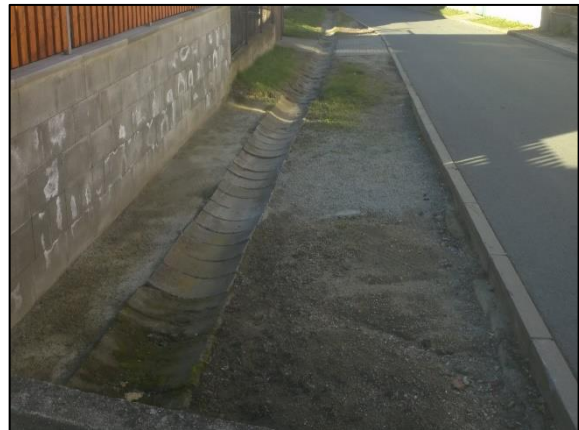
Obr. 4 - Betonové žlabovky ve spodní části ulice Pod Špičákem
