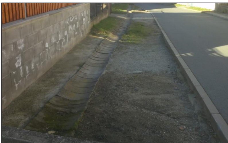
Obr. 19 - Betonové žlabovky ve spodní části ulice Pod Špičákem
