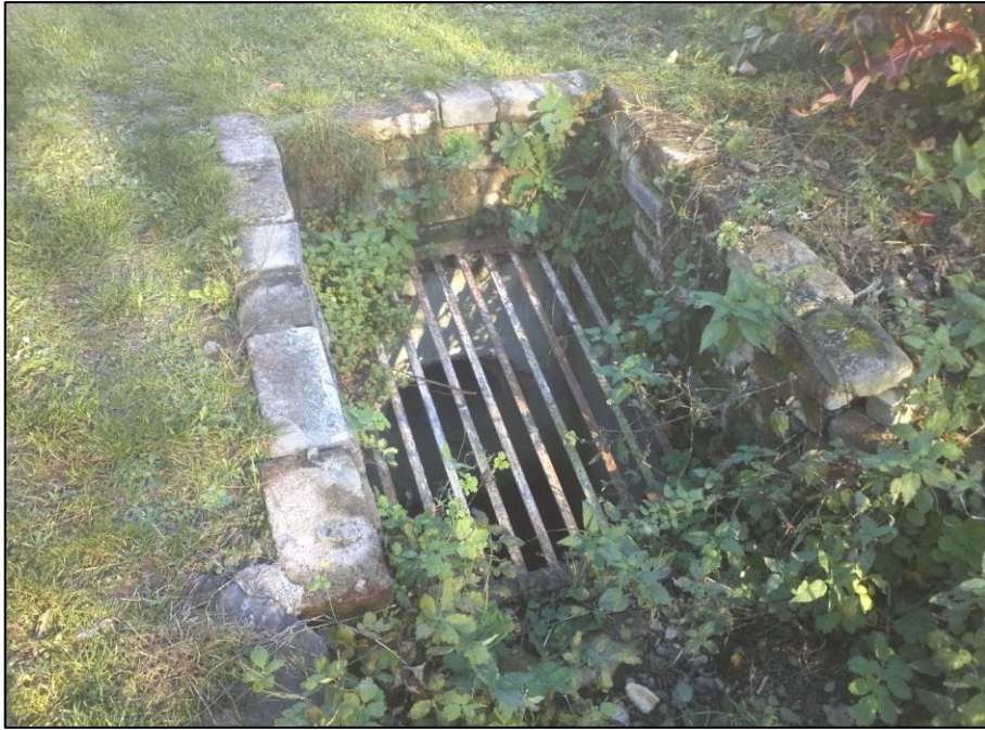
Obr. 17 - Horská vpust na výstupu ze sprášové rokle s odtokovým potrubím DN 400
