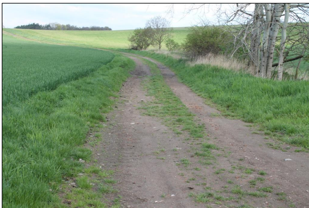
Obr. 15 - Částečně zpevněná polní cesta
