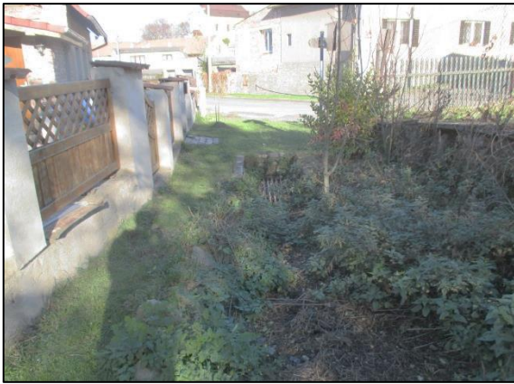
Obr. 1 - Přítok do horské vpusti na výstupu ze sprašové rokle
