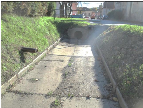
Obr. 9 - Vyústění dešťové kanalizace a odtoku z krytého žlábků do otevřeného příkopu
