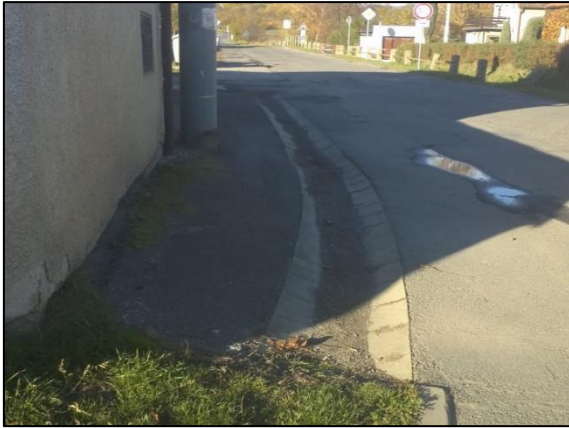
Obr. 7 - Betonové žlabovky na křížení ulice 9. Května a ulice u Kovárny
