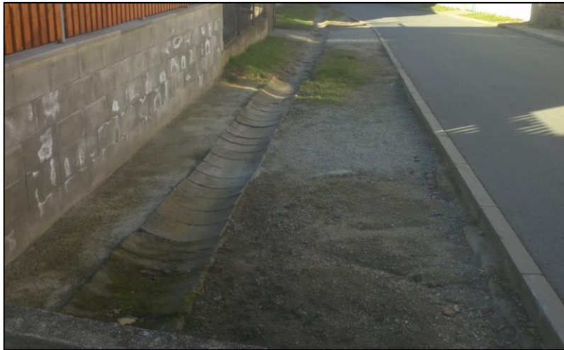
Obr. 19 - Betonové žlabovky ve spodní části ulice Pod Špičákem
