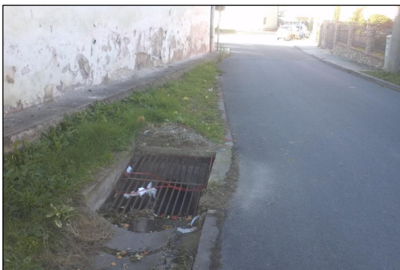
Obr. 20 - Horská vpust s odtokovým potrubím DN 400 v ulici Pod Špičákem
