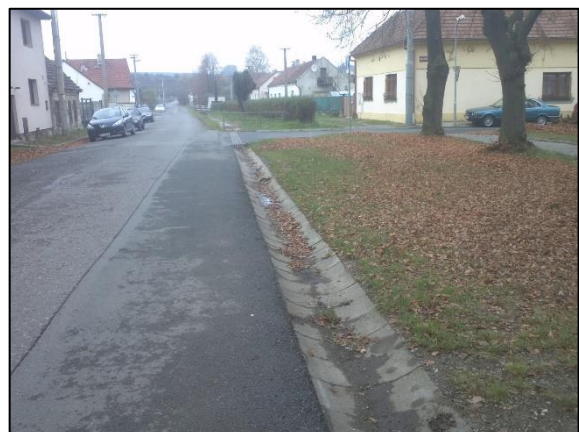
Obr. 6 - Betonové žlabovky v ulici 9.Května
