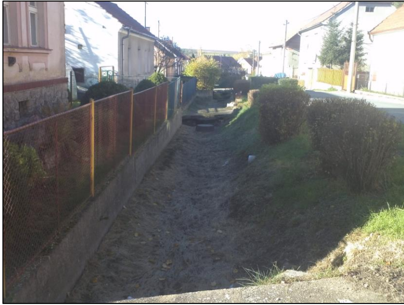
Obr. 18 - Otevřený příkop v ulici Pod Špičákem
