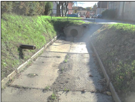
Obr. 9 - Vyústění dešťové kanalizace a odtoku z krytého žlabku do otevřeného příkopu
