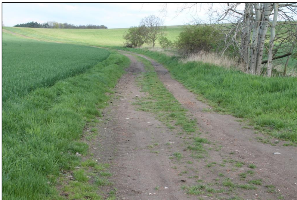
Obr. 15 - Částečně zpevněná polní cesta
