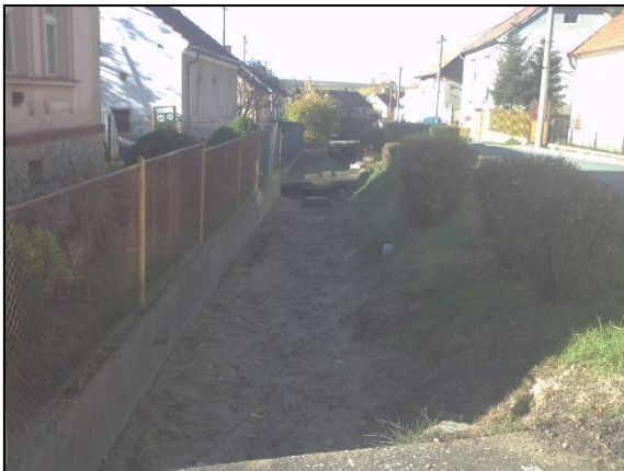
Obr. 3 - Otevřený příkop v ulici Pod Špičákem
