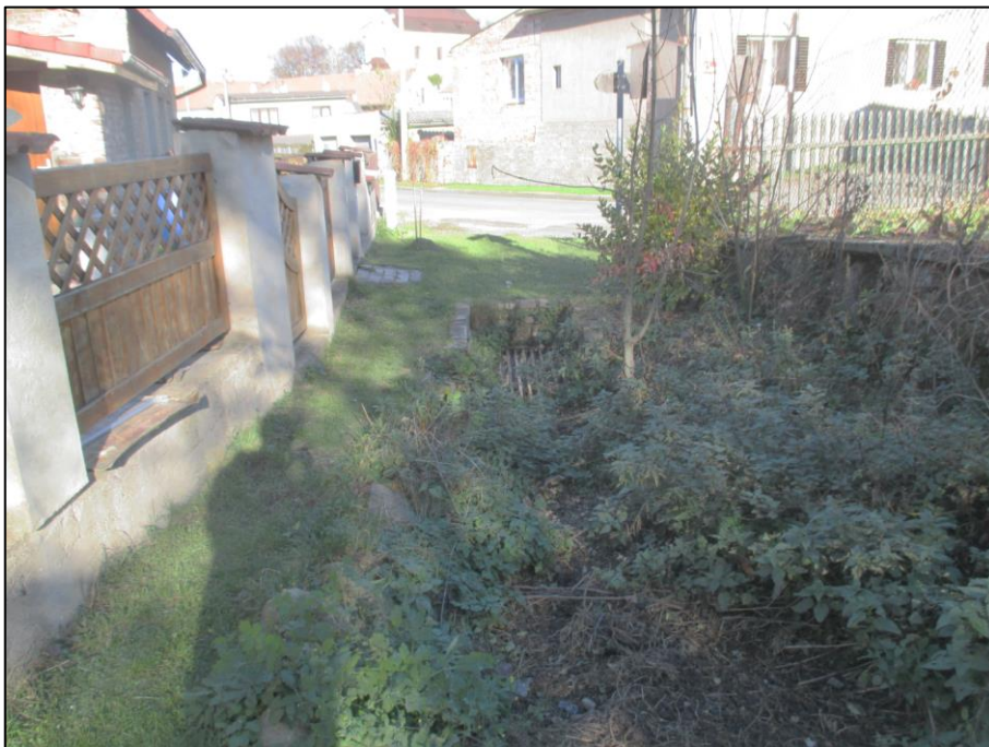
Obr. 16 - Přítok do horské vpusti na výstupu ze sprašové rokle
