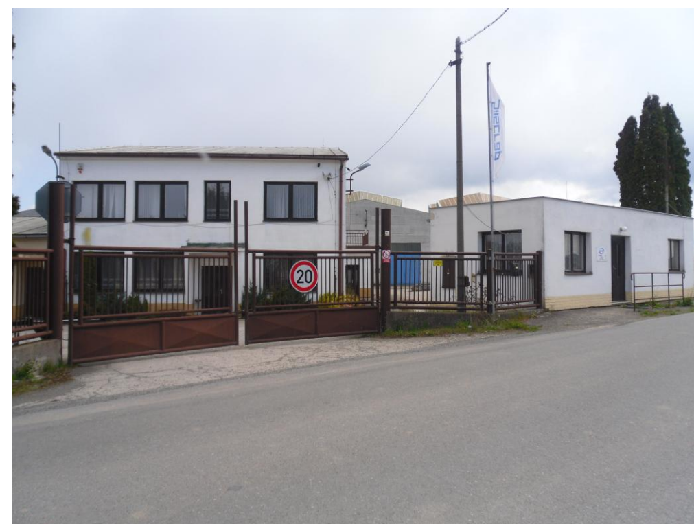
Obrázek 4 - Vjezd do firmy SILCSCRAP a.s.
